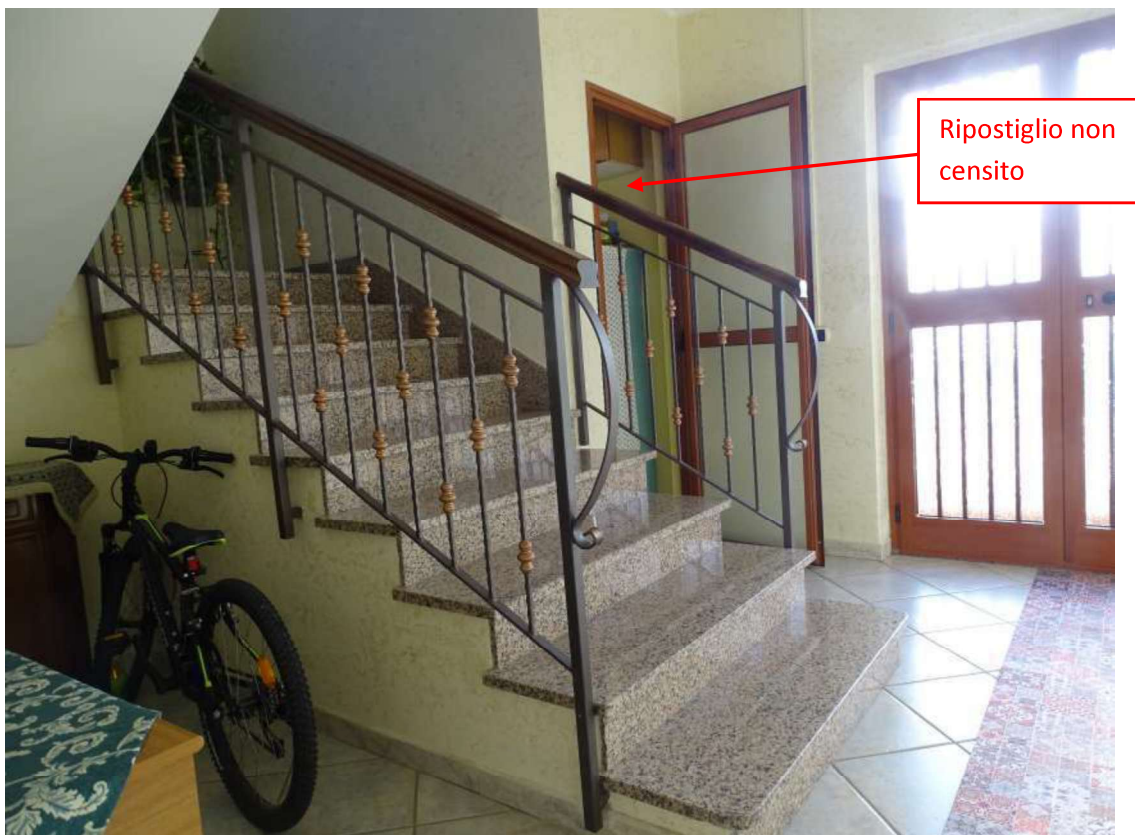
Foto 8 – Particolare portone di accesso e vano scala
