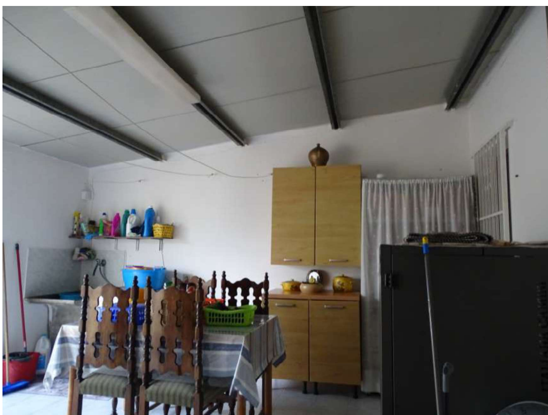
Foto 12 – Immobile “A” - Particolare dell’ampliamento sul lato N-O
