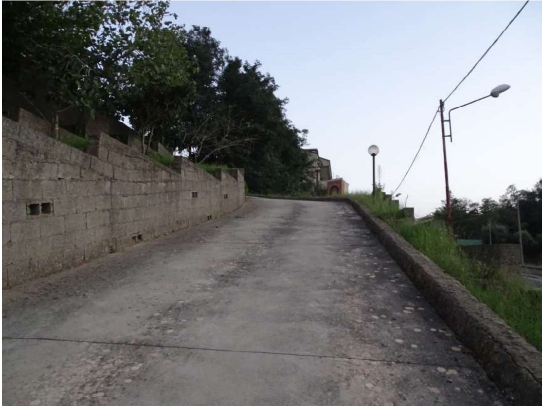
Foto 3 – Particolare rampa di accesso
