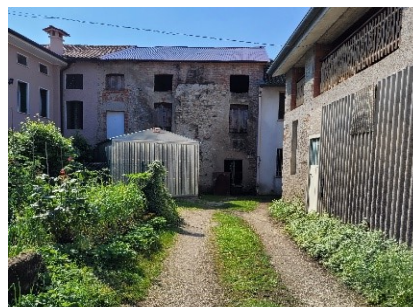
PROSPETTO NORD 2024 (post intervento)
