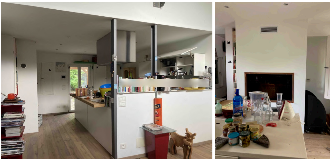
Viste interne: piano "sottostrada": vano "cucina"
