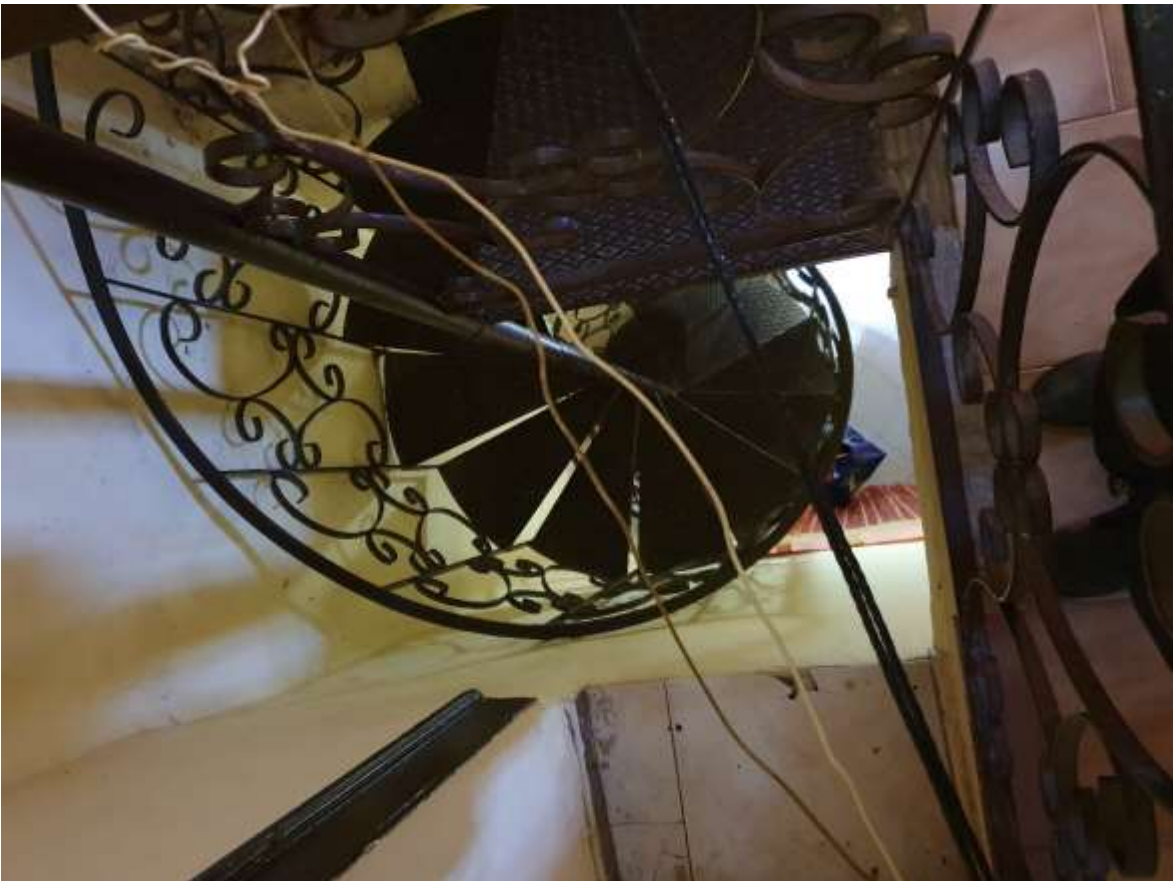
Smonto scala al primo piano
