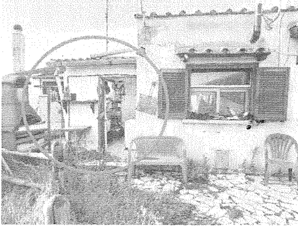
Corpo aggiunto al fabbricato principale destinato ad abitazione fg. 15 p.lla 157 sub 5
