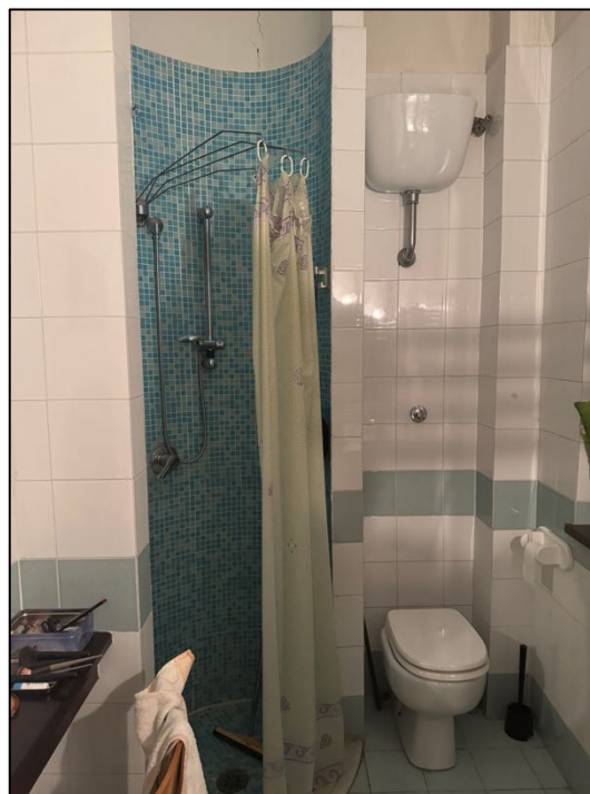
Foto 32 – Bagno Camera n.1
