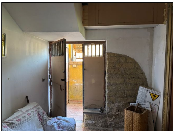
Foto 47 – Accesso esterno al piano seminterrato.
