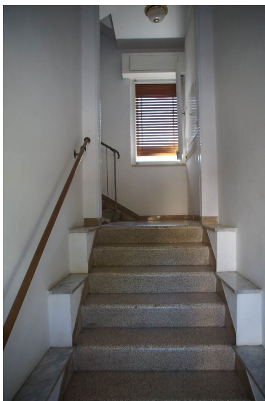
Foto n°4: particolare del vano scala interno allo stabile dove è ubicato il bene A.
