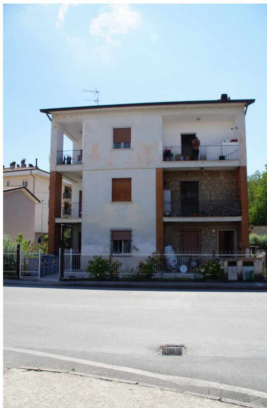
Foto n°1: vista lato Nord-Est del fabbricato, si noti l'accesso pedonale alla corte condominiale recintata con cancello e gli alloggi esterni dei contatori di gas e acqua.
