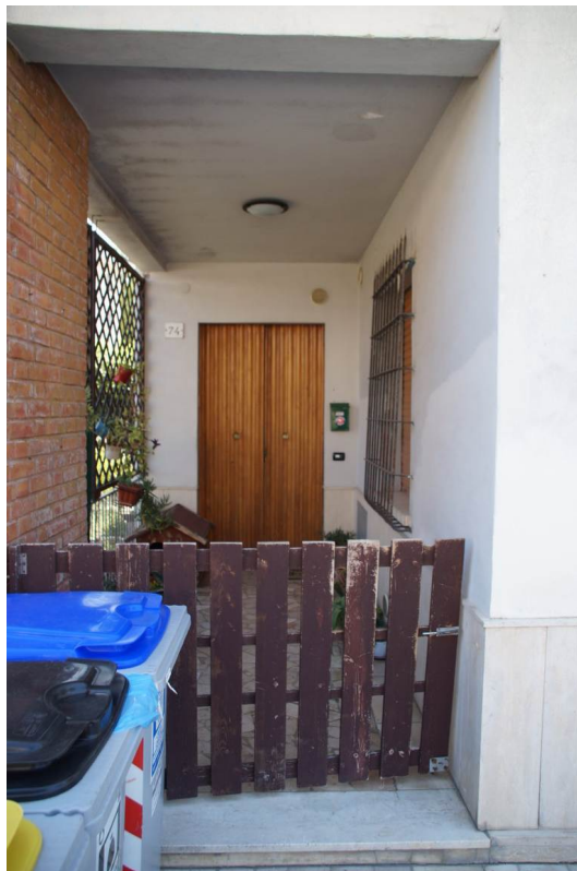
Foto n°16: particolare del portoncino d'ingresso all'appartamento posto lungo il lato Nord-Est del fabbricato.
