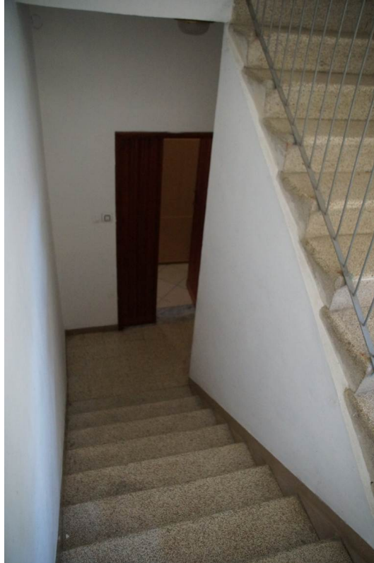
Foto n°7: altro particolare interno del vano scala, si noti il portone d'ingresso del bene A.
