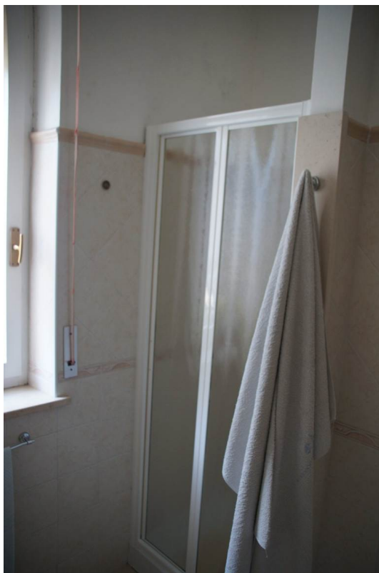
Foto n°25: particolare del box doccia e della nicchia realizzata per ospitarlo non presente nella planimetria.
