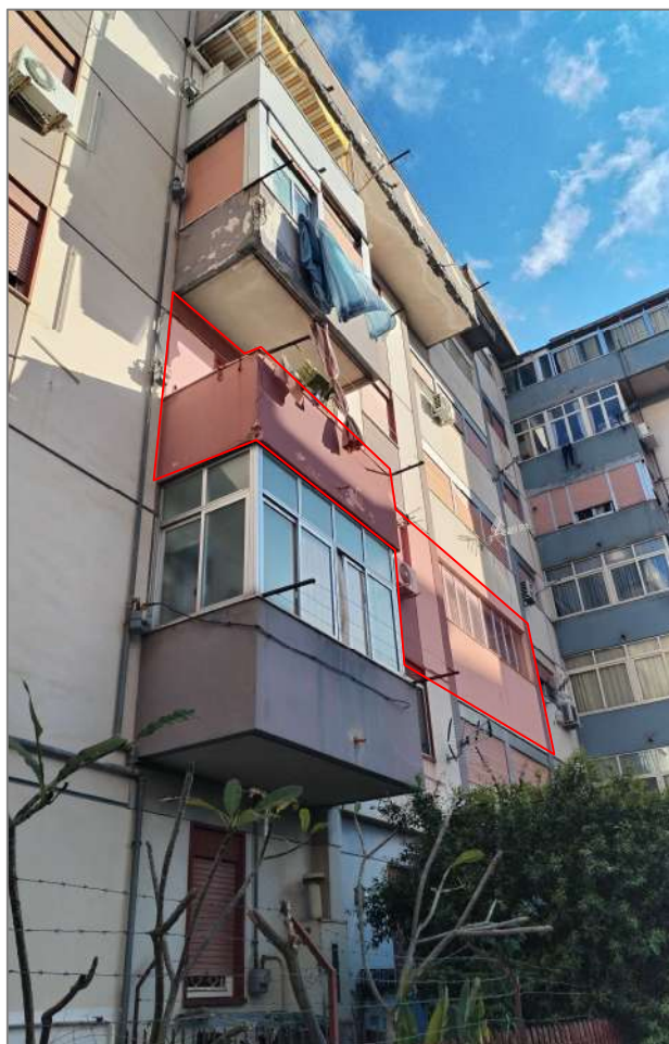
Prospetto esposto a nord-est. In rosso l'immobile oggetto di pignoramento.
