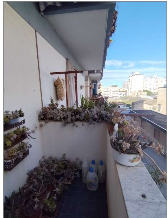
Balcone su prospetto principale afferente alla sala da pranzo
