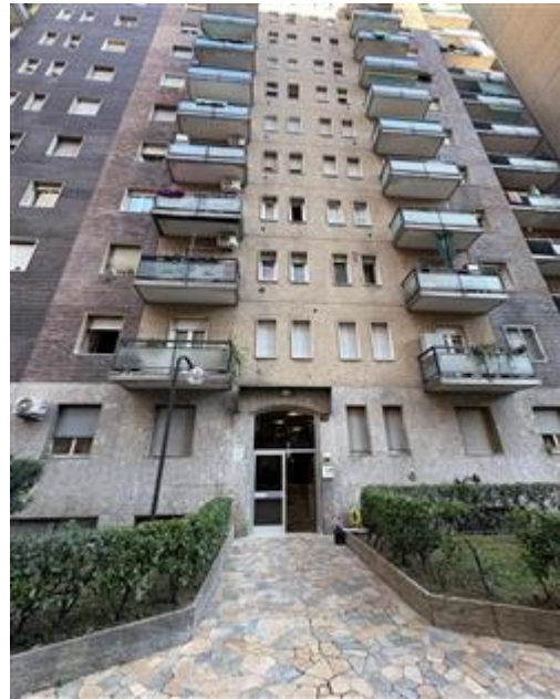
Vista del fabbricato condominiale
