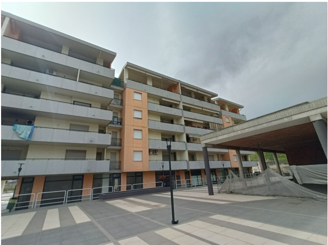
Immobile sito in Pescara alla Via di Sotto n.3/1, Piani quarto e quinto, Scala C, Palazzina B distinto al Foglio n.18 Particella n.2874 Sub. n.141.
