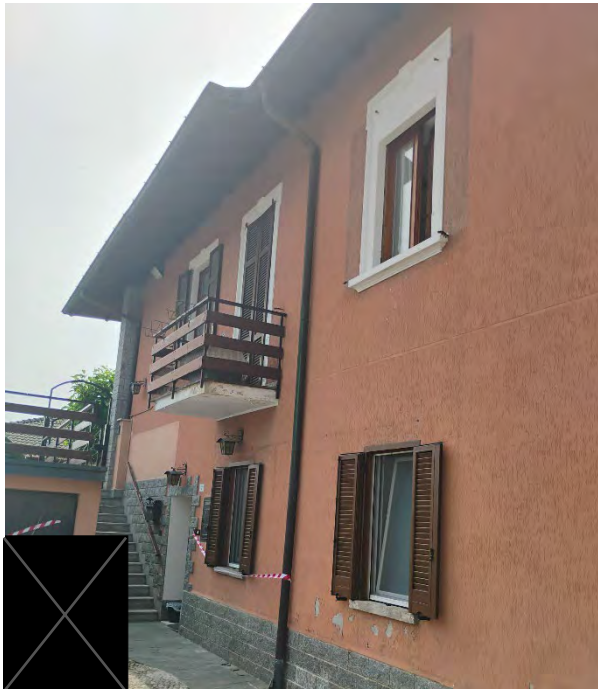
Facciata principale – ingresso principale
