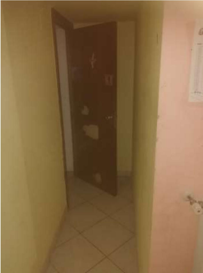
10. Foto interno disimpegno al piano secondo (la porta di ingresso alla seconda camera da letto - presenta buchi)
