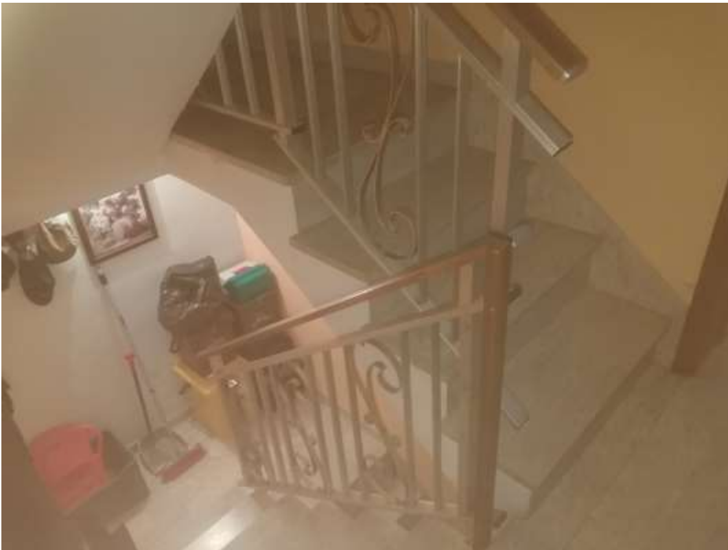
5. Foto interno vano scala piano primo-piano terra
