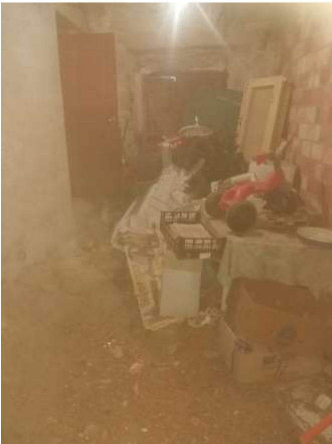
3. Foto interno locale cantina piano terra/seminterrato
