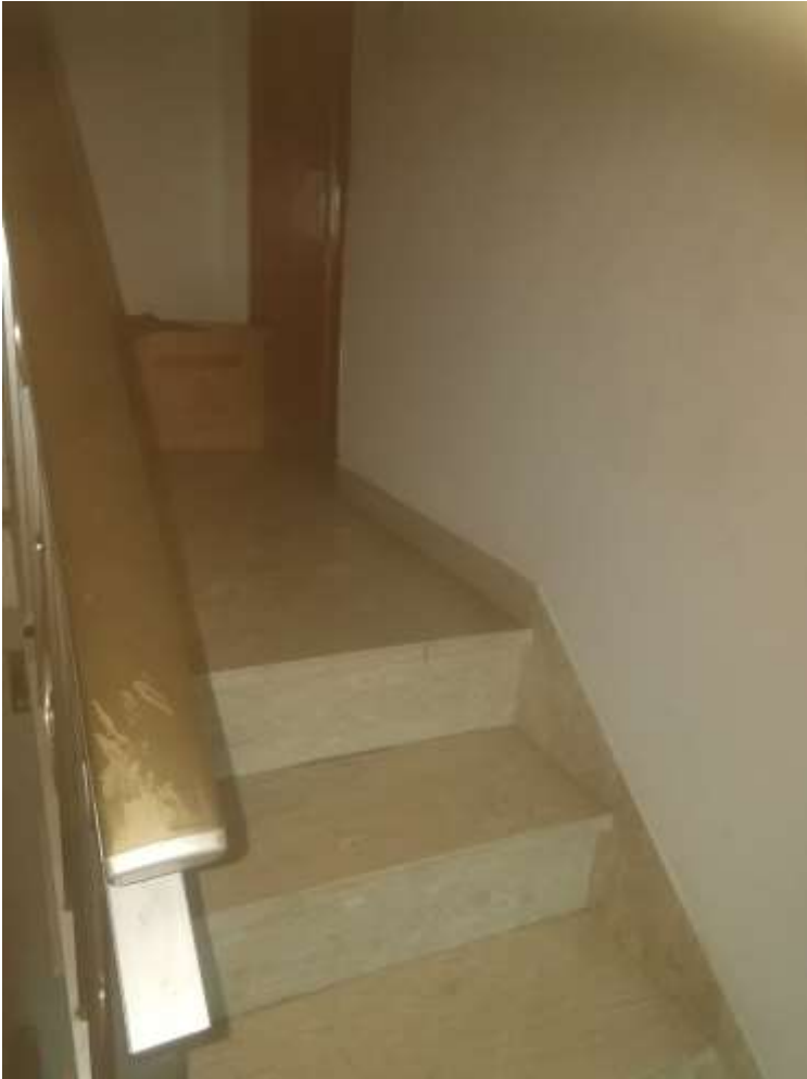
12. Foto interno scala di accesso al piano terzo
