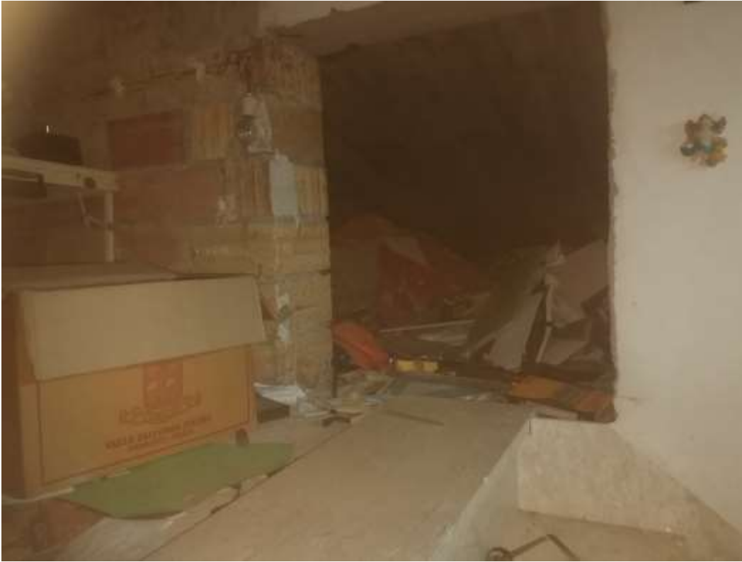
16. Foto interno sottotetto/soffitta (direzione opposta alla foto n. 15)
