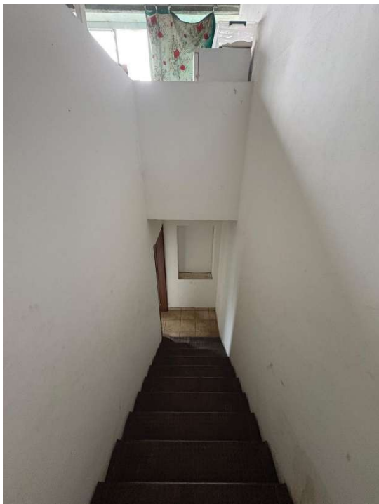
Scale di collegamento
