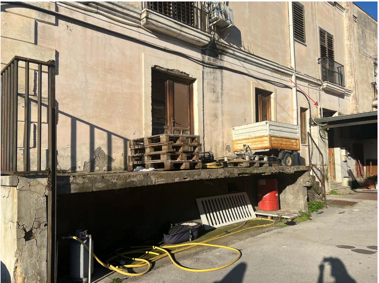
Foto 4 - Vista degli accessi all'unità p.la 25-sub 11
