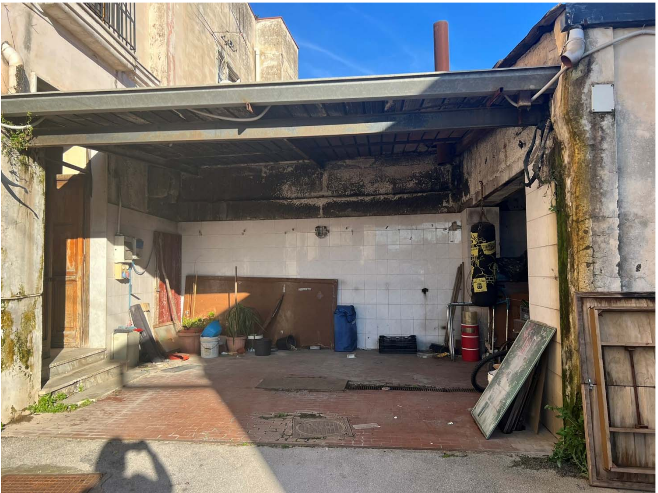
Foto 15 – Particolare della prima area deposito – p.lla 1075
