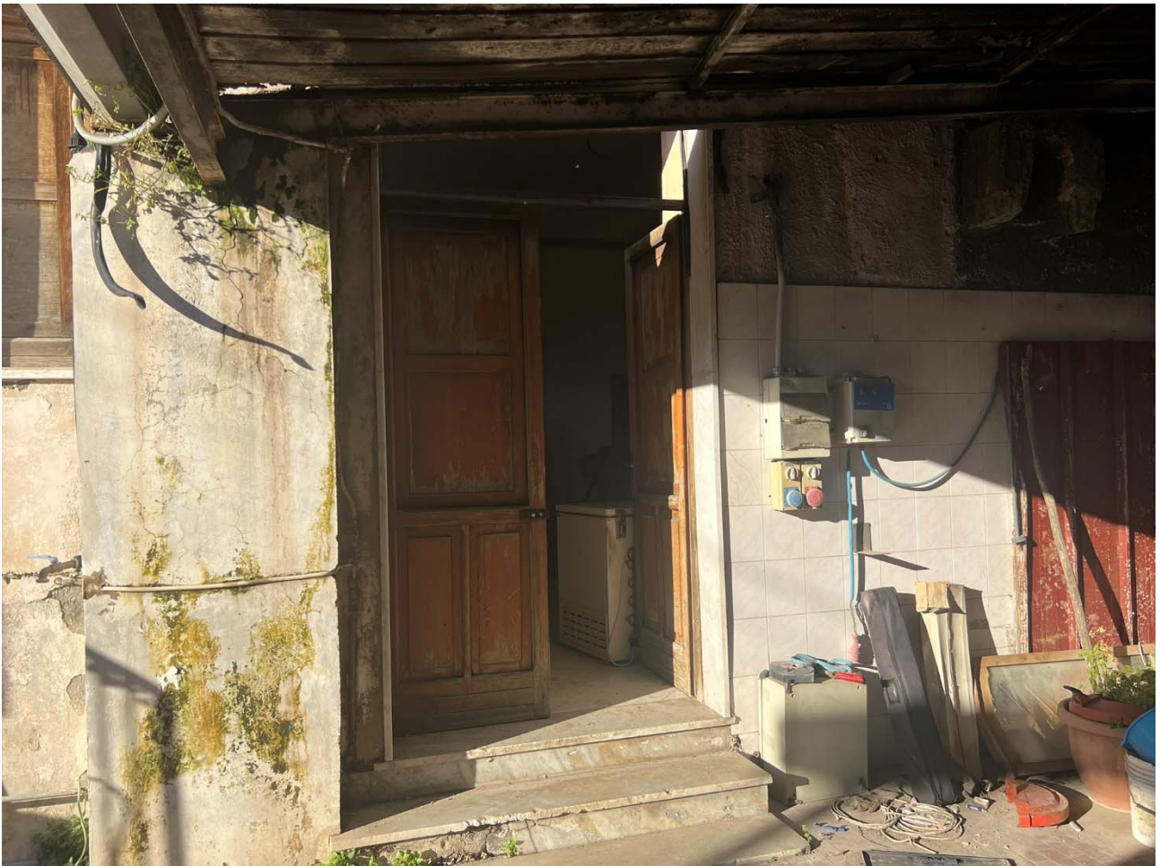
Foto 6 – Vista degli accessi all'unità p.lla 25-sub 11
