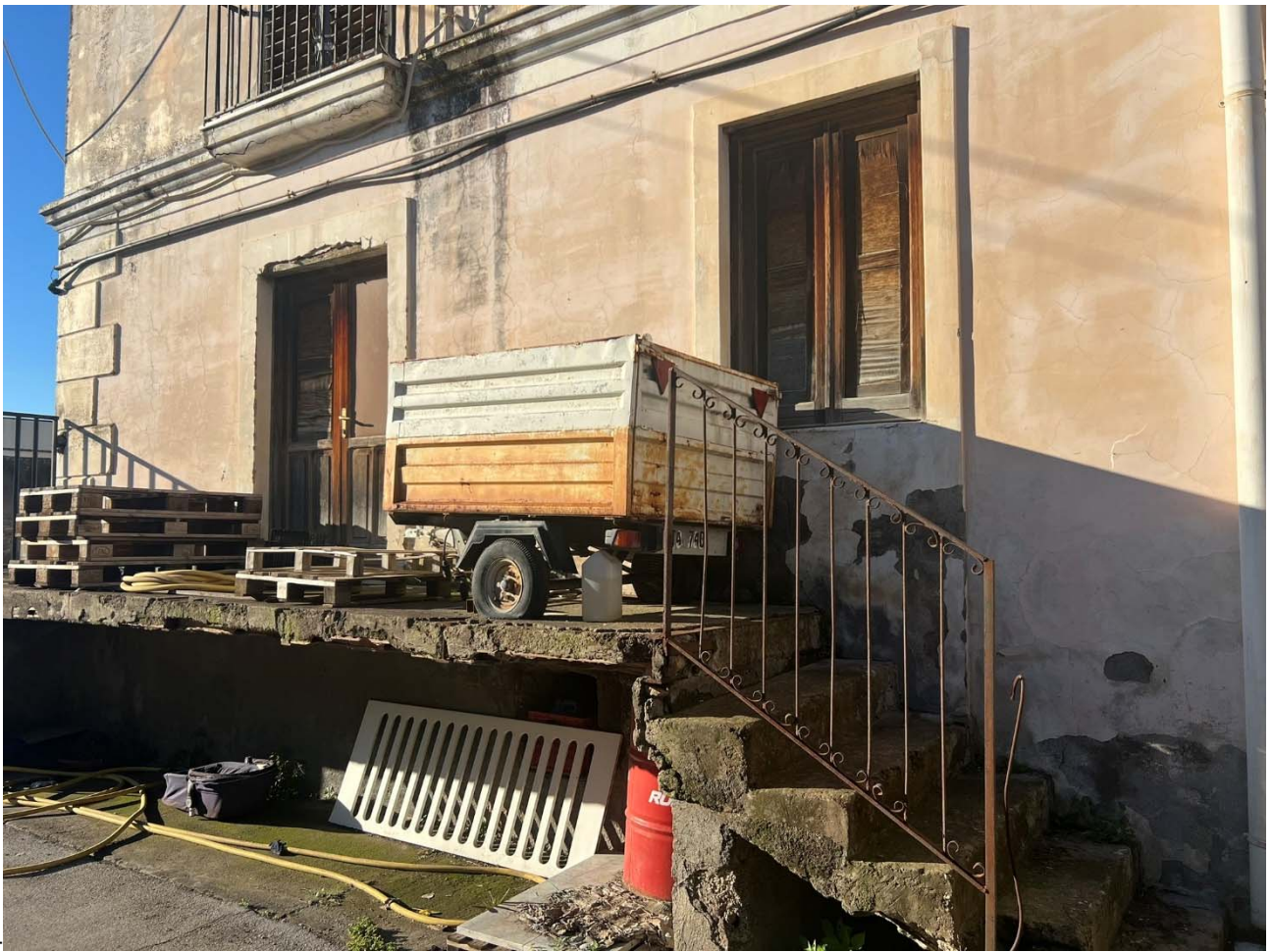
Foto 5 – Vista degli accessi all'unità p.lla 25-sub 11
