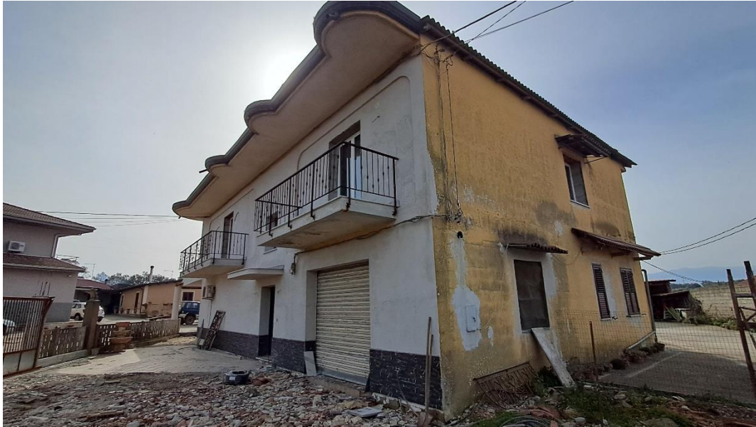
Foto 1: Catasto Fabbricati di Rizziconi, foglio 20, particella 417 – fabbricato a due piani fuori terra visto da nord-ovest.
