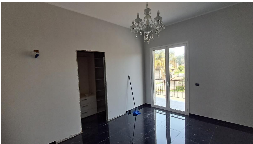
Foto 11: Catasto Fabbricati di Rizziconi, foglio 20, particella 417 – appartamento al primo piano. Camera con cabina armadio.
