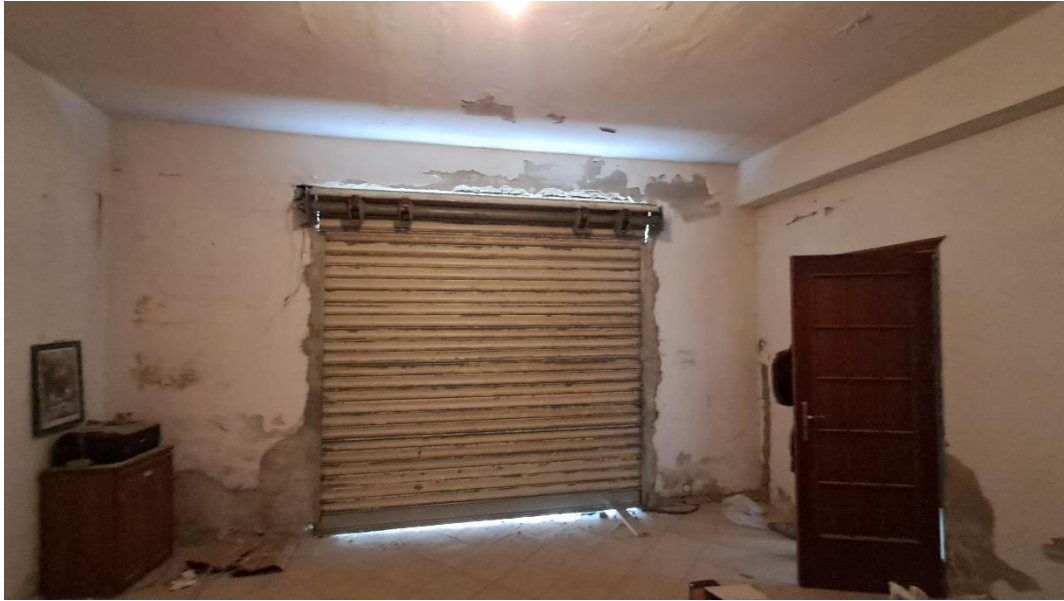
Foto 7: Catasto Fabbricati di Rizziconi, foglio 20, particella 417 – deposito al piano terra.
