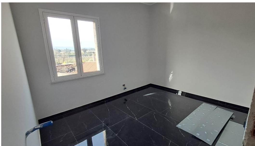
Foto 12: Catasto Fabbricati di Rizziconi, foglio 20, particella 417 – appartamento al primo piano. Camera.
