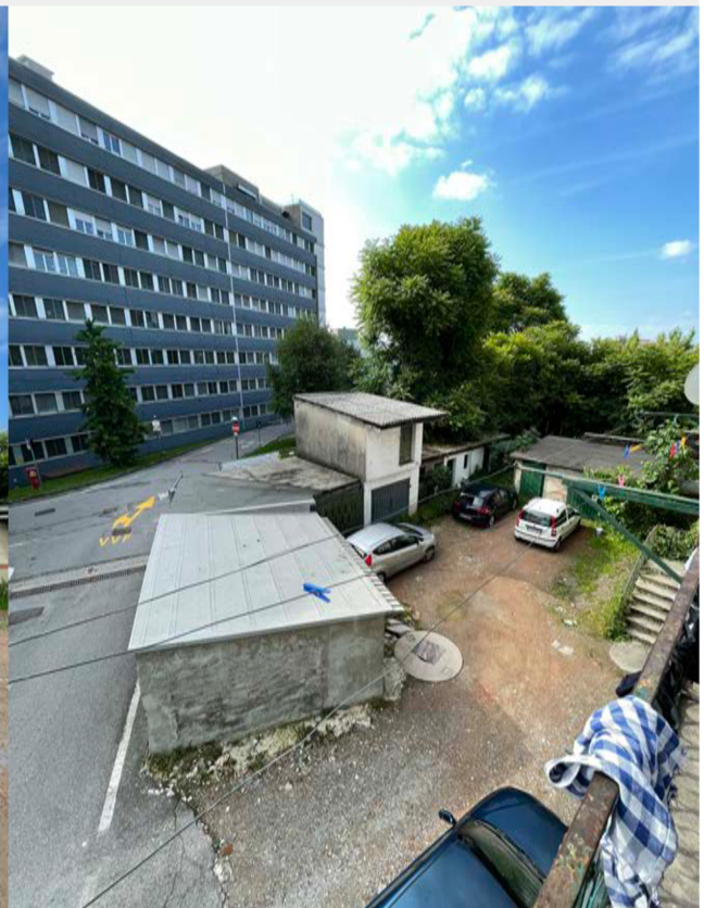
Fig. 4 - Cortile comune Vista verso il cortile comune
