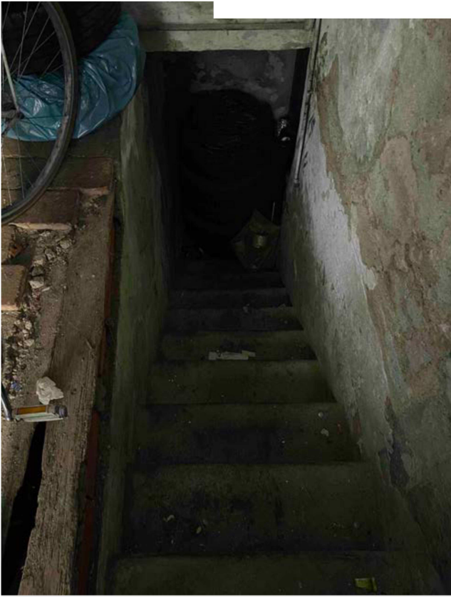
Fig. 25 - scala di proprietà Verso cantina di proprietà
