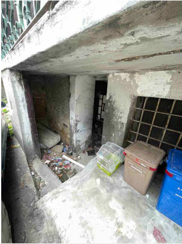
Fig. 29 - scala di proprietà Verso cantina di proprietà
