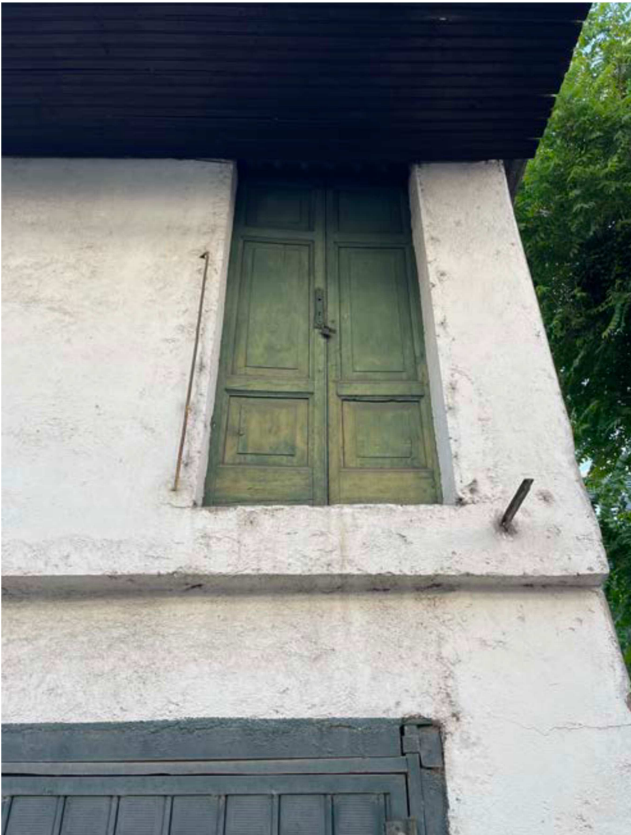
Fig. 1 - Prospetto principale deposito Vista di dettaglio lato nord ovest
