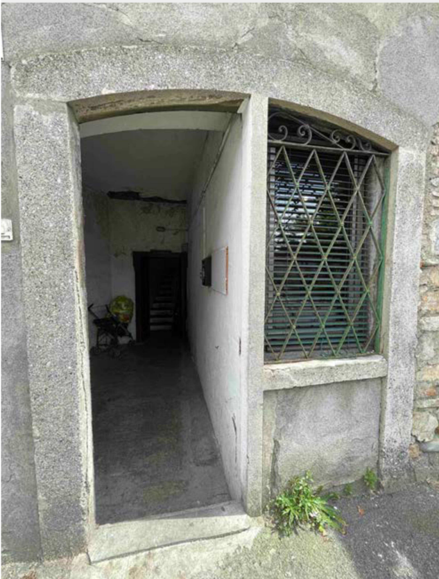
Fig. 27 - accesso comune Verso scala di proprietà
