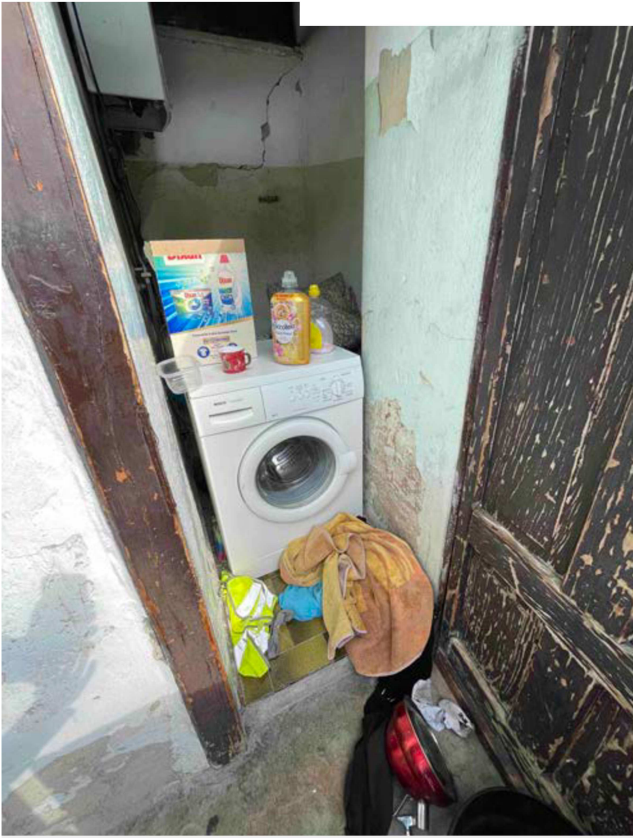
Fig. 9 - Ripostiglio Accesso dal Balcone 1
