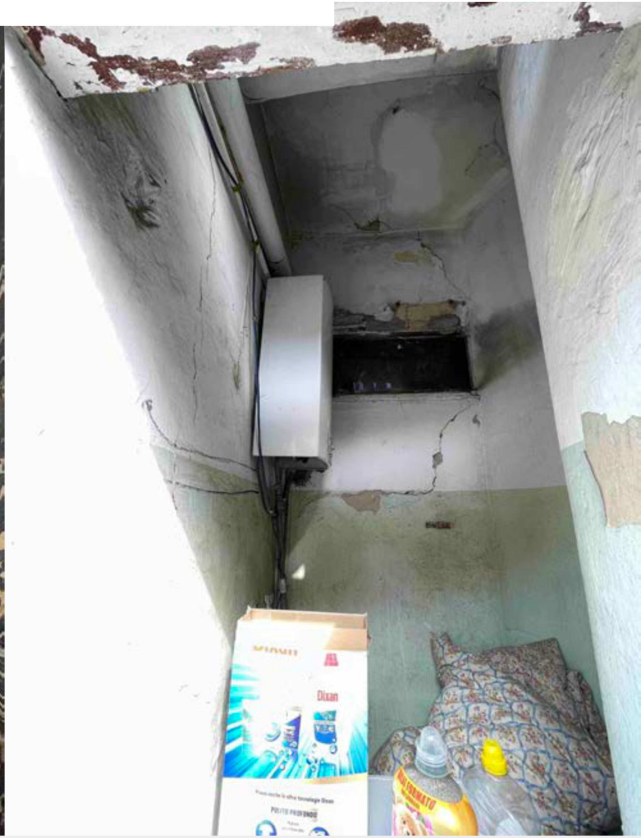
Fig. 10 - Ripostiglio Accesso dal Balcone 1
