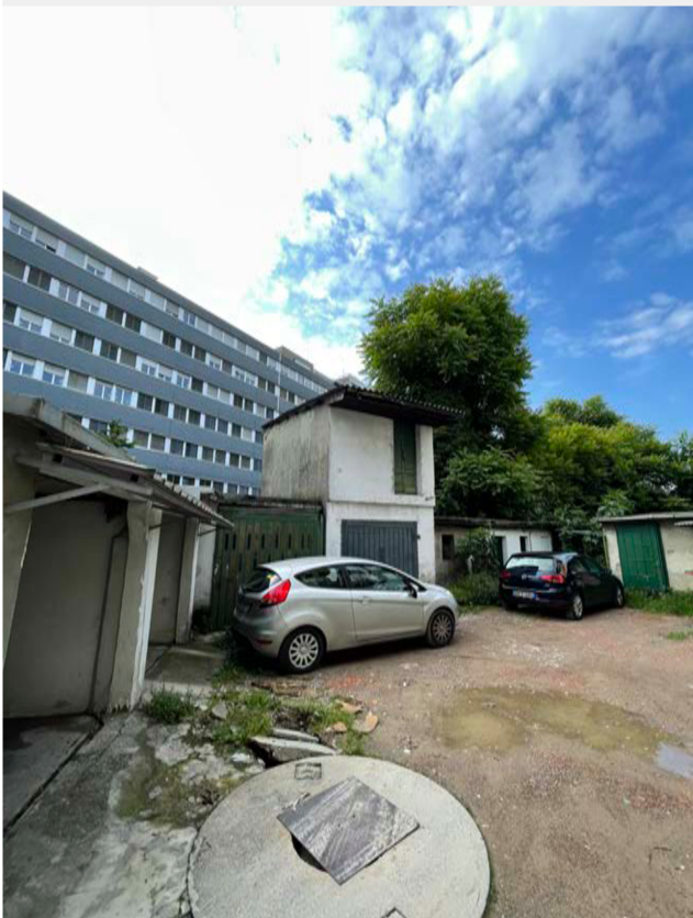
Fig. 3 - Cortile comune Vista verso prospetto principale
