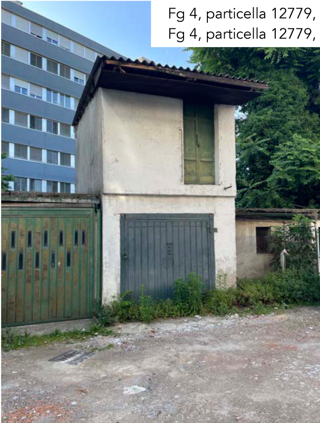
Fig. 1 - Prospetto principale lato nord ovest Vista dalla cortile comune
