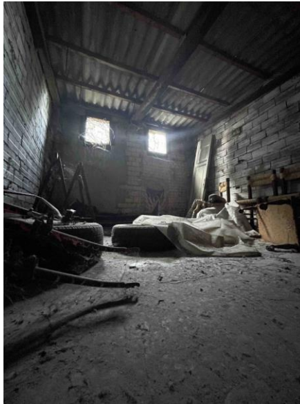
Interno del Deposito
