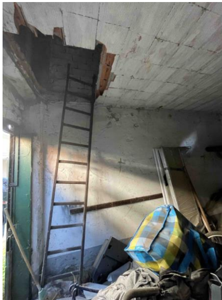
Scala di accesso al deposito
