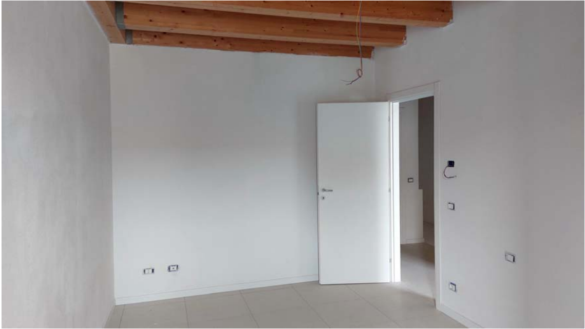
5) Vista di una camera
