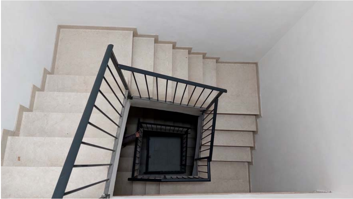
17) Vista del vano scala condominiale.
