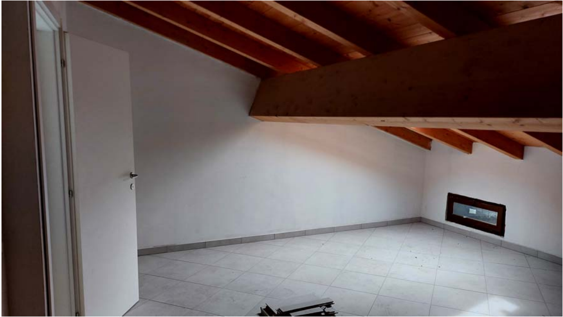
15) Vista della soffitta.
