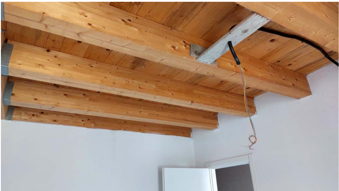
6) Vista di una camera
