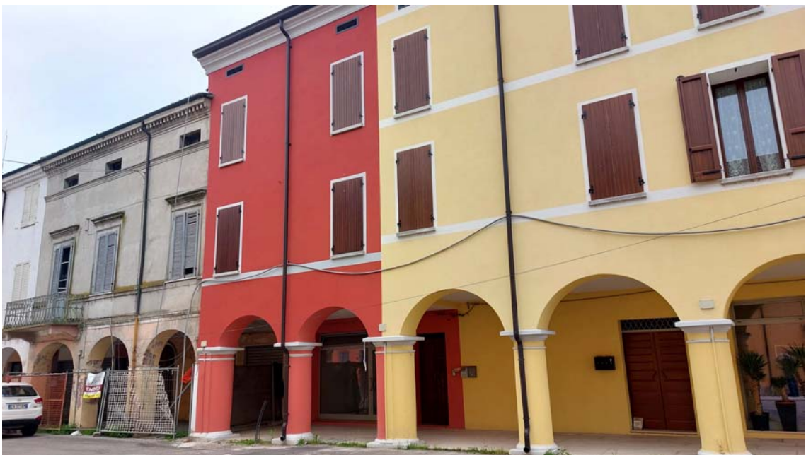
24) Vista esterna del fabbricato.
