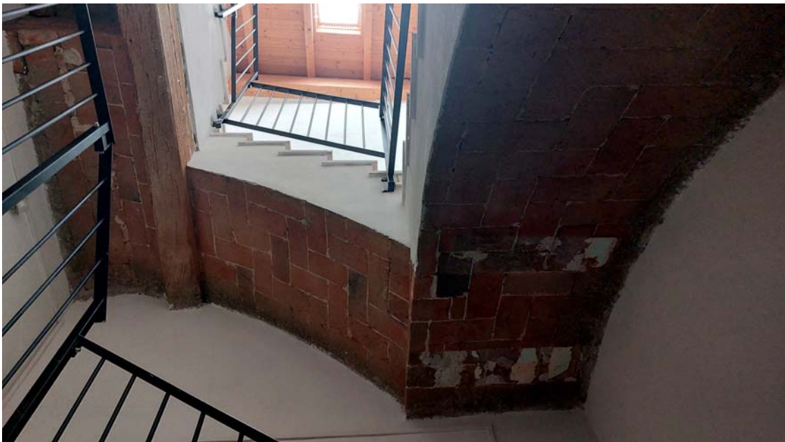
18) Particolare del vano scala condominiale.
