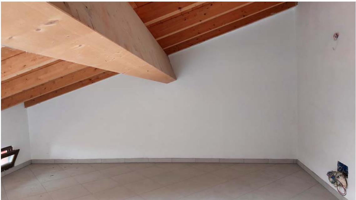
14) Vista della soffitta.
