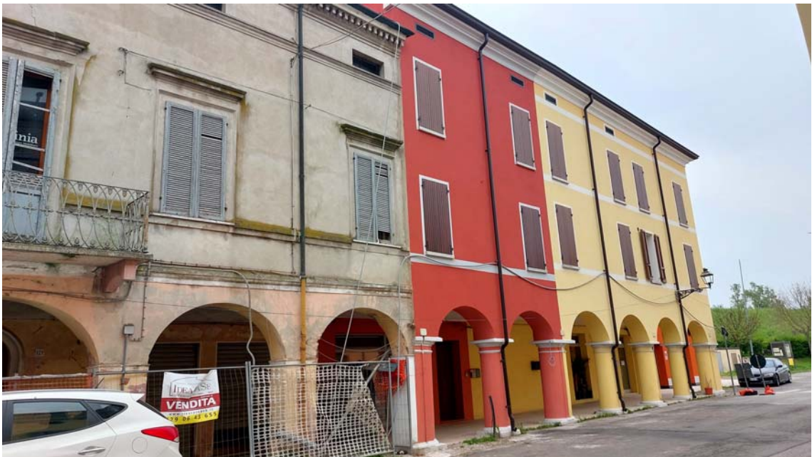
22) Vista esterna del fabbricato.
