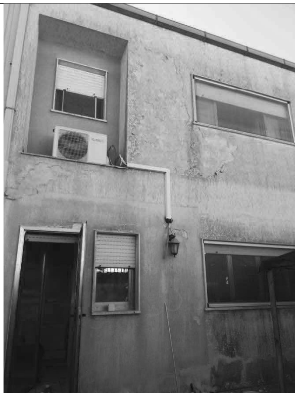
FOTO N.7 – IMMOBILE PIGNORATO INGRESSO POSTERIORE
