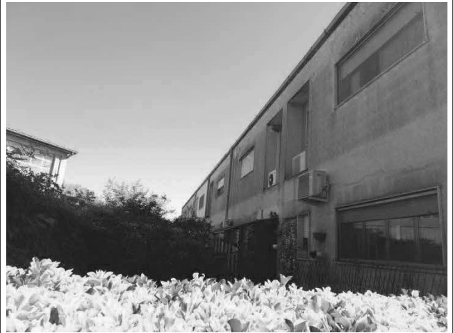
FOTO N.5 – IMMOBILE PIGNORATO RETRO PROSPETTO
