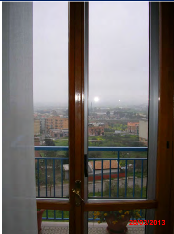
5 - Particolare infissi esterni (1)
