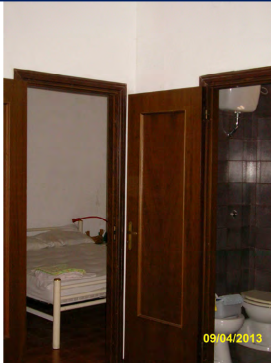
23 - Interno proprietà [redacted]: infissi interni
