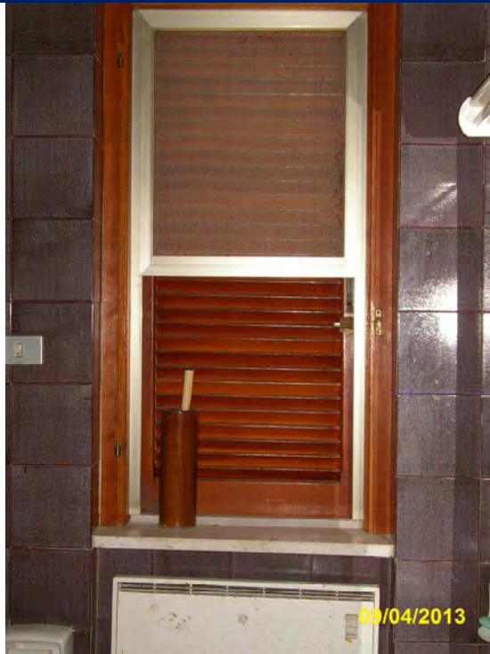
21 - Interno proprietà [redacted] : infissi interni
