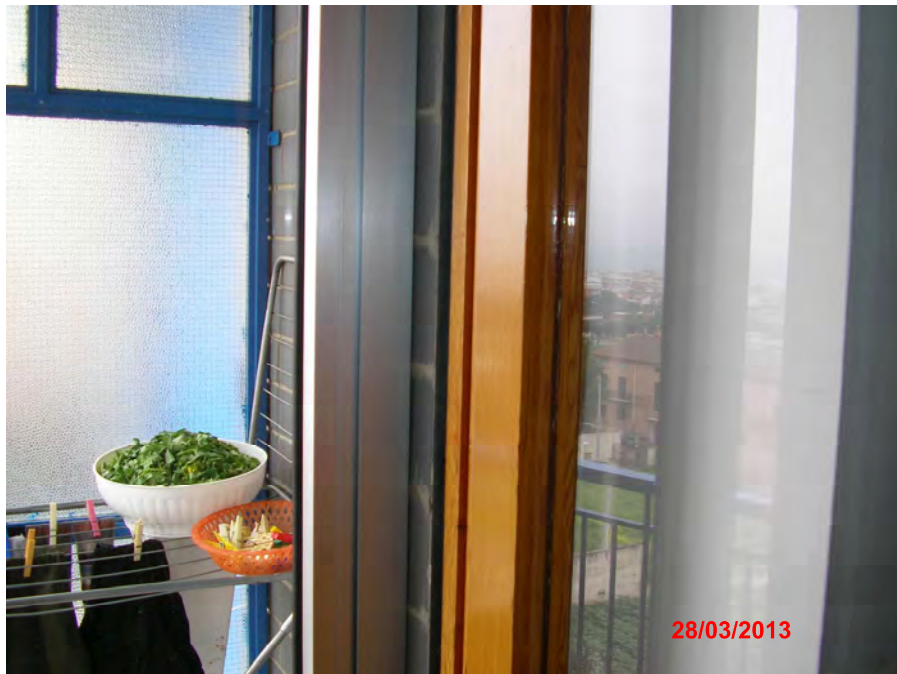
10 - Particolare infissi esterni (3)
