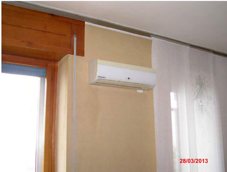
6 - Particolare infissi esterni (2)
