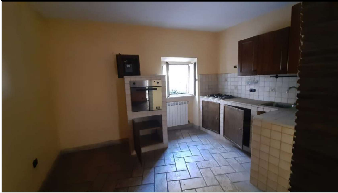
Foto 6 – rilievo interno – cucina piano primo
