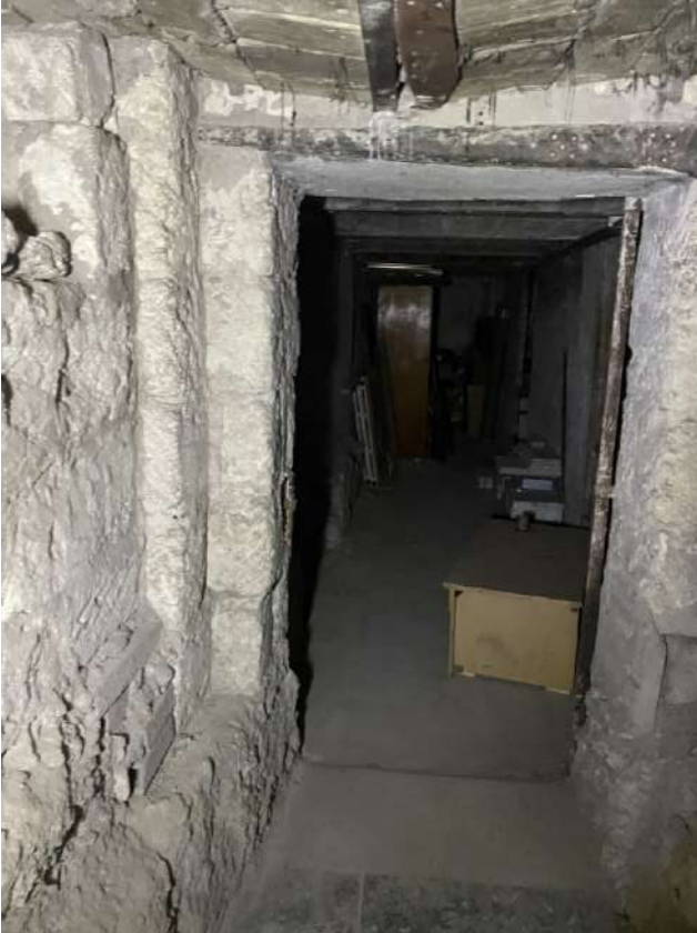
Figura 11. LOTTO UNICO: Immobile pignorato al F. 96, P.Illa 5921, Sub. 4 ubicato in Foggia alla Via Vittime Civili n. 68 (corridoio comune di accesso al deposito posto al piano seminterrato).
