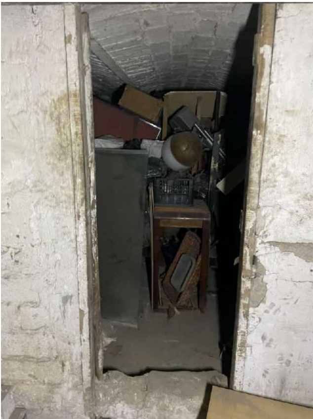
Figura 12. LOTTO UNICO: Immobile pignorato al F. 96, P.Illa 5921, Sub. 4 ubicato in Foggia alla Via Vittime Civili n. 68 (deposito posto al piano seminterrato).
