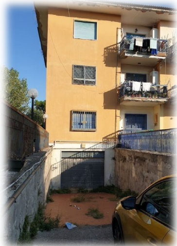
Accesso esterno dalla rampa lato strada
