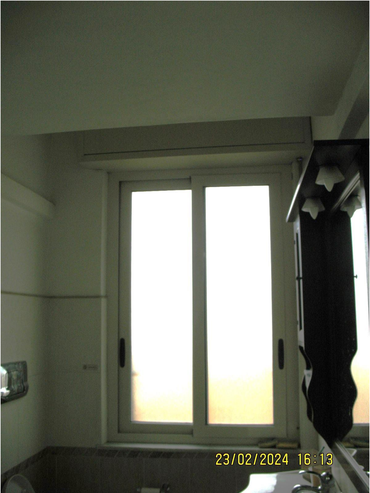
12-Bagno lato sud con finestra su Via Gorizia
