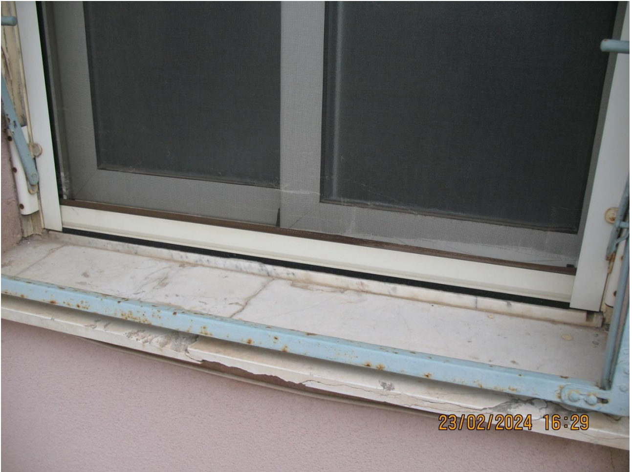
25-Finestra del bagno dal balcone prospiciente su Via Gorizia con infisso dotato di telaio a semi-imbotte interna e zanzariera esterna su soglia di marmo esterna
