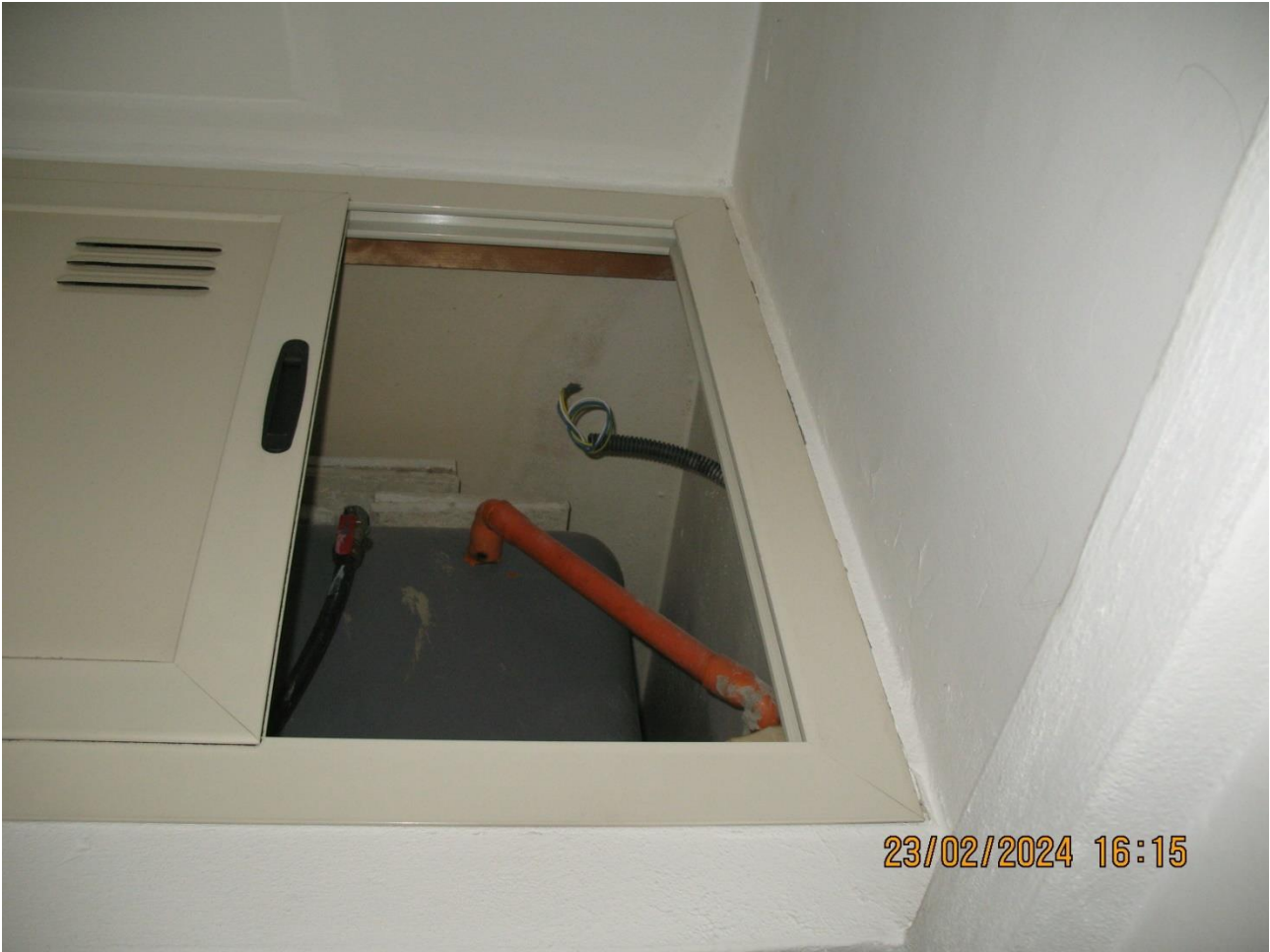
14-Bagno lato sud con ribassamento tetto per riserva idrica con serbatoio in polietilene
