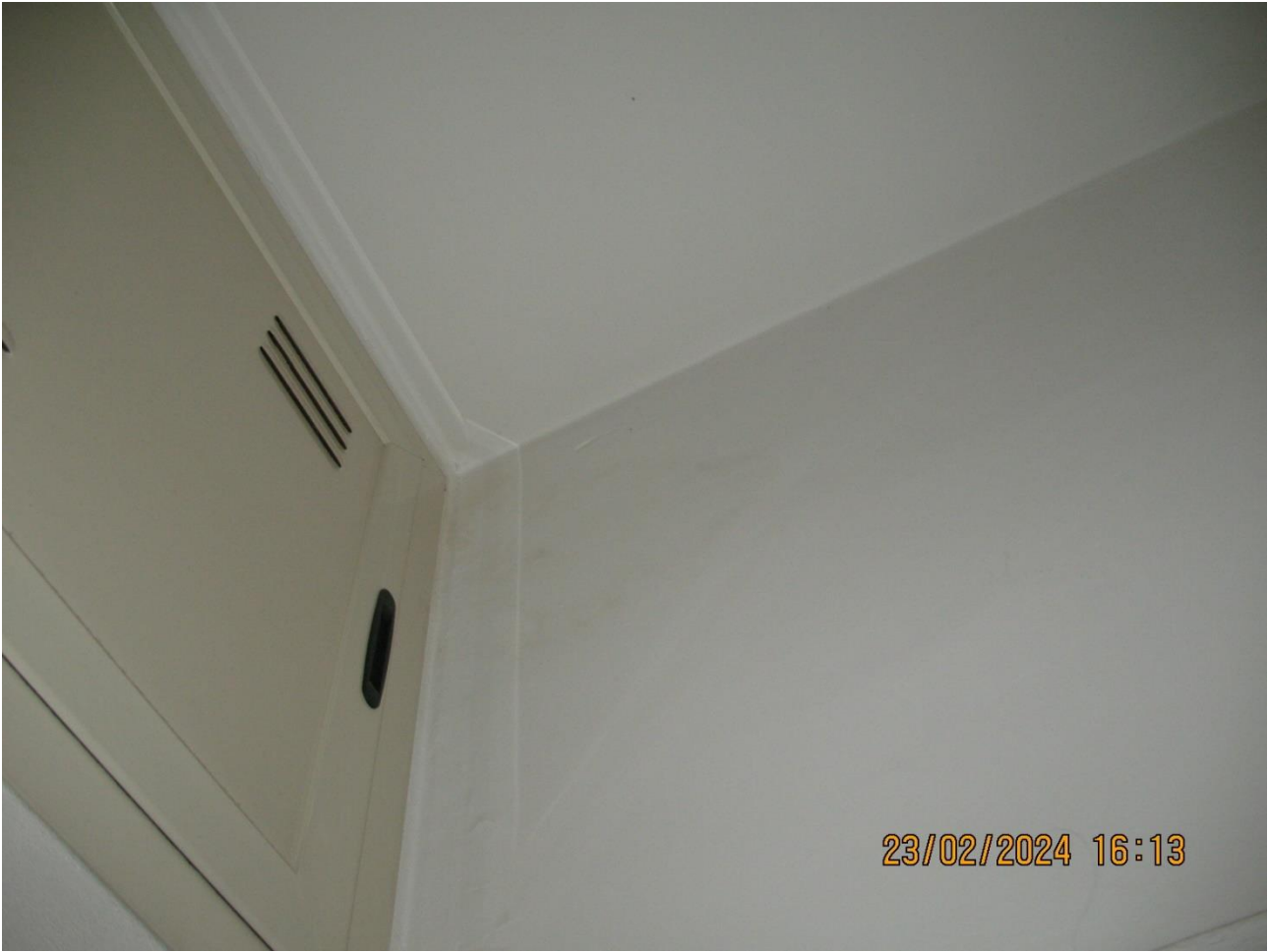
13-Bagno lato sud con ribassamento tetto per riserva idrica
