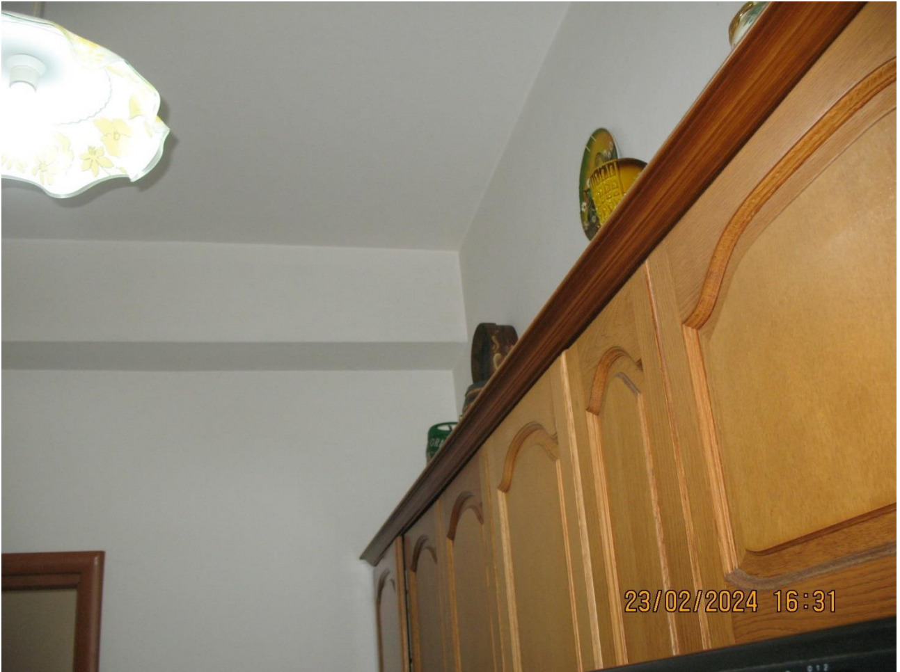
33-Cucina lato sud su Via Gorizia
