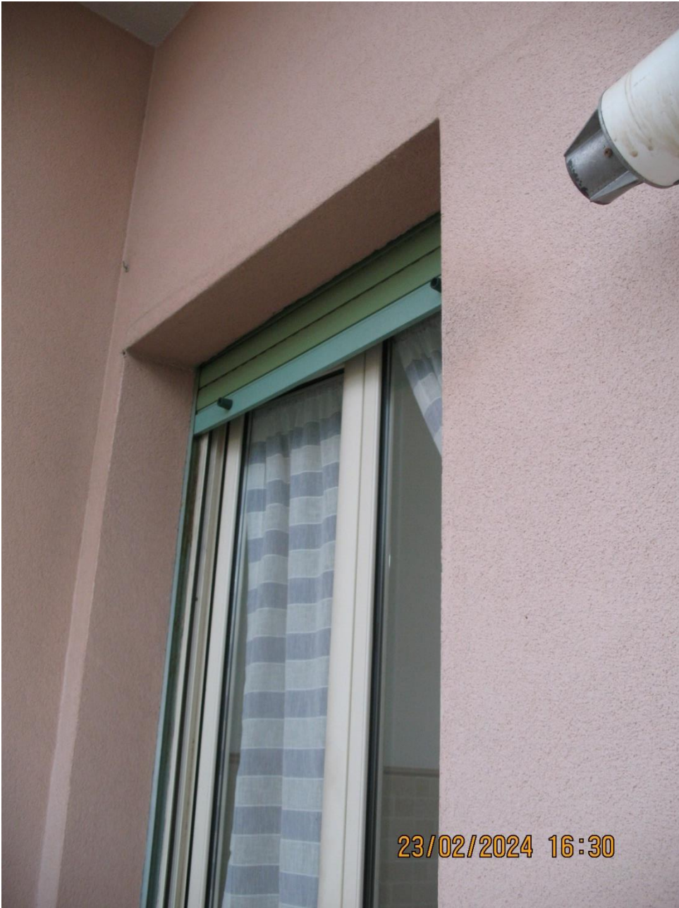
28-Apertura della cucina dal balcone prospiciente su Via Gorizia con infisso dotato di telaio a semi-imbotte interna e zanzariera esterna
