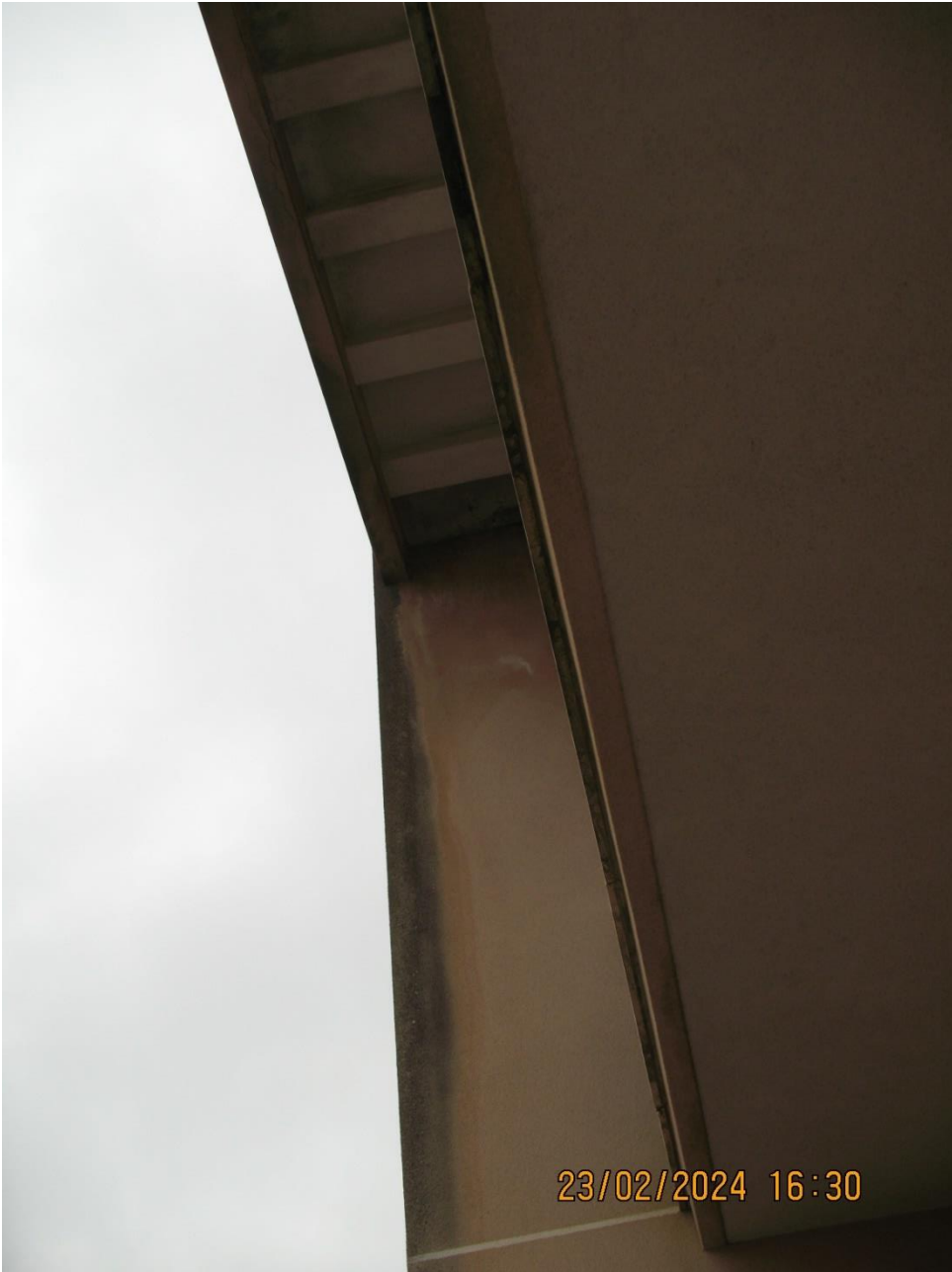
27-Prospetto esterno dal balcone prospiciente su Via Gorizia
