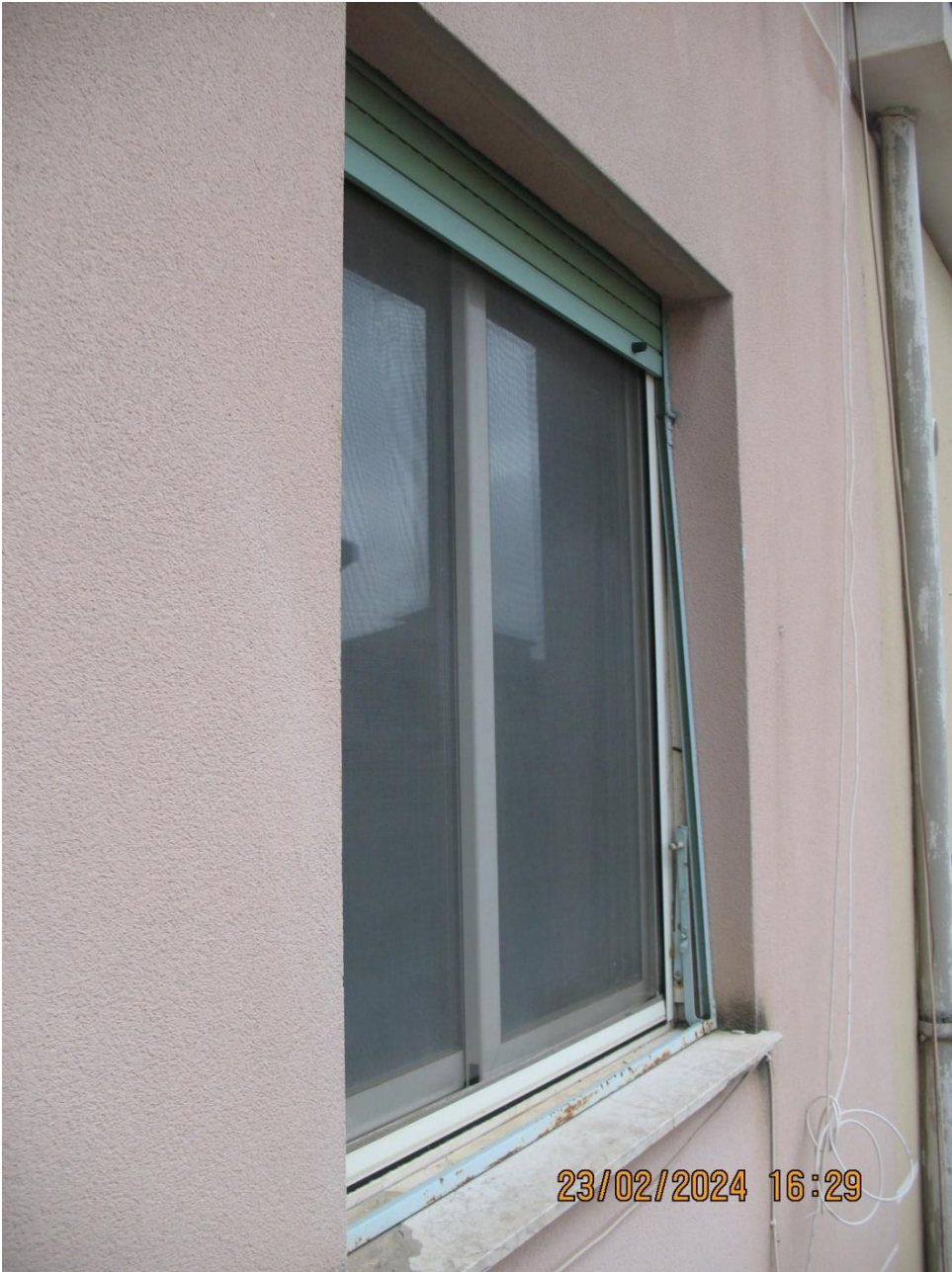
24-Finestra del bagno dal balcone prospiciente su Via Gorizia con infisso dotato di telaio a semi-imbotte interna e soglia di marmo esterna
