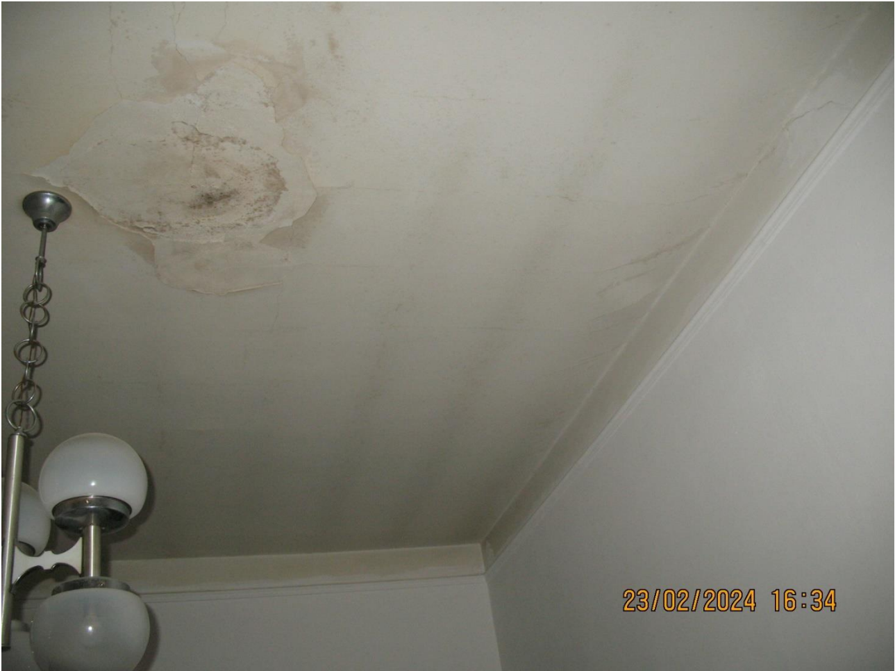
40-Soggiorno lato nord
