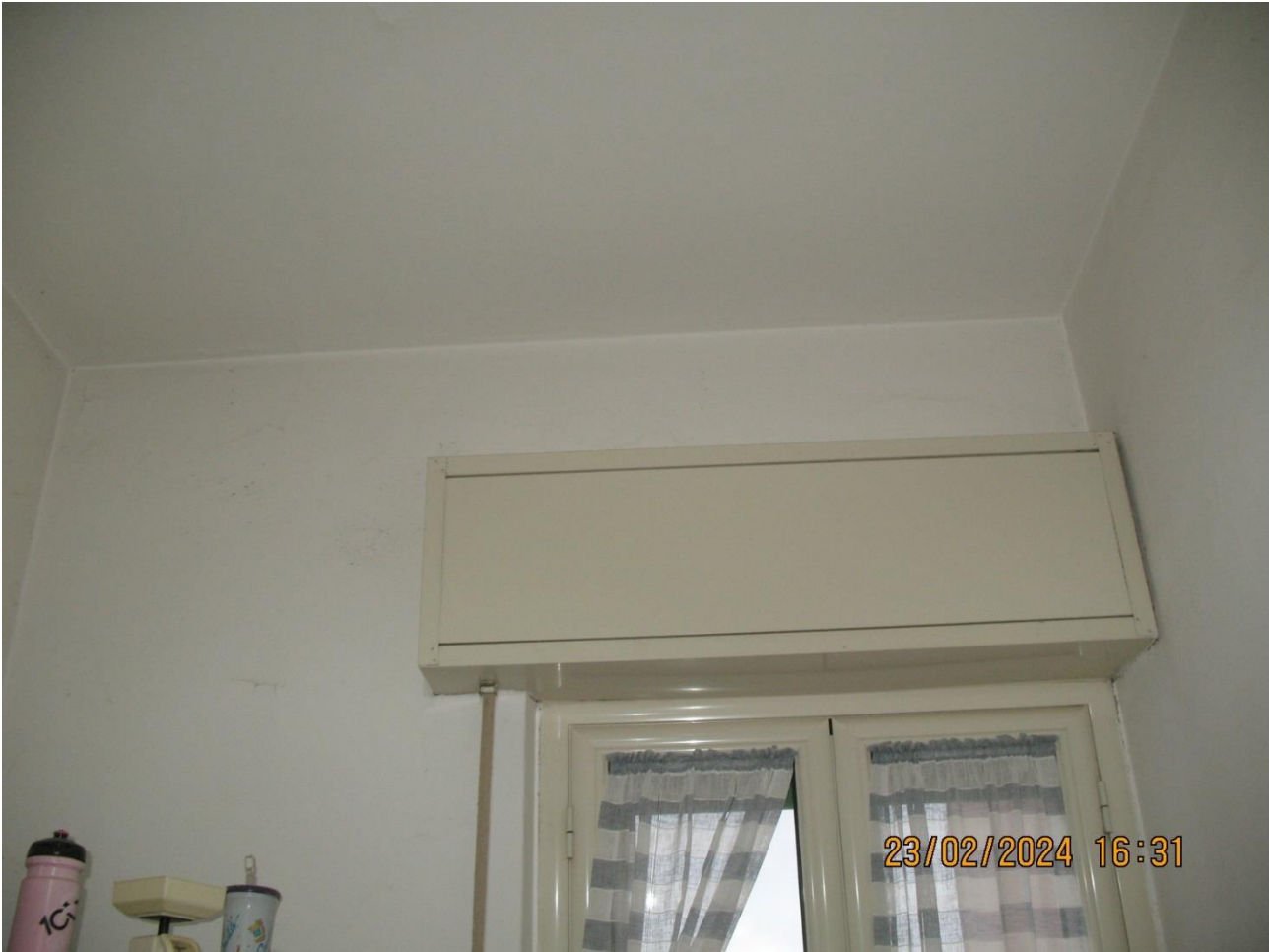
32-Cucina lato sud su Via Gorizia con apertura su balcone esterno
