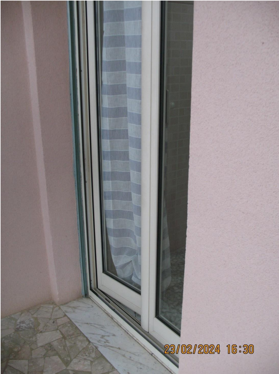
29-Apertura della cucina dal balcone prospiciente su Via Gorizia con infisso dotato di telaio a semi-imbotte interna e zanzariera esterna
