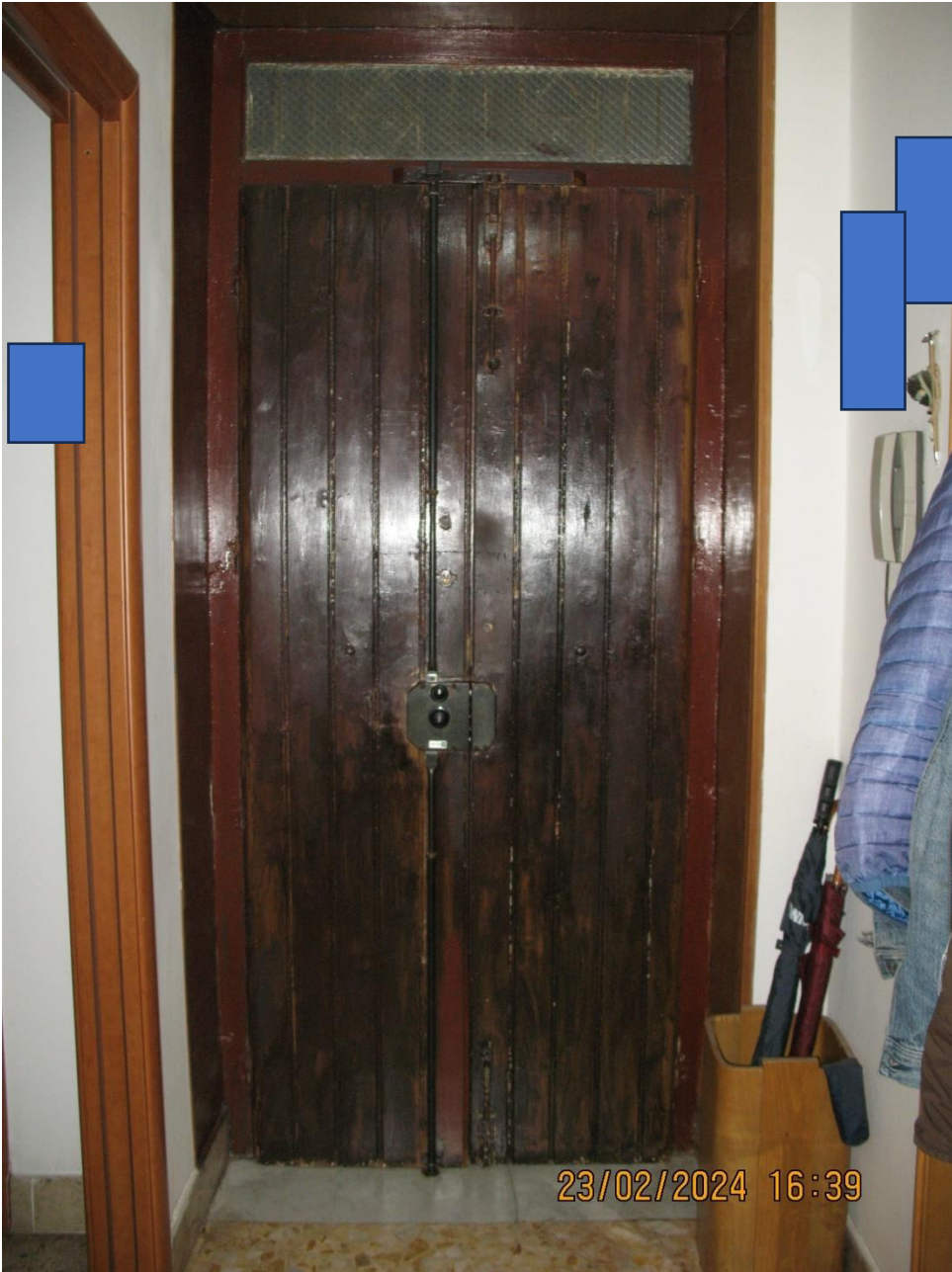
43-Porta di accesso all'immobile dal vano ingresso
