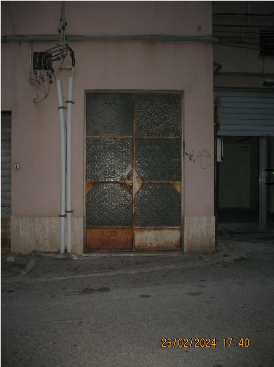
49-Portone di accesso secondario su Via Gorizia n°44
