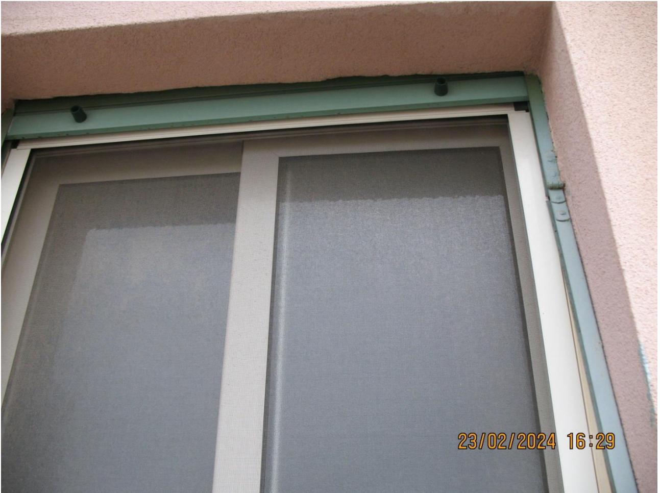
23-Finestra del bagno dal balcone prospiciente su Via Gorizia con avvolgibili in legno con guide mobili
