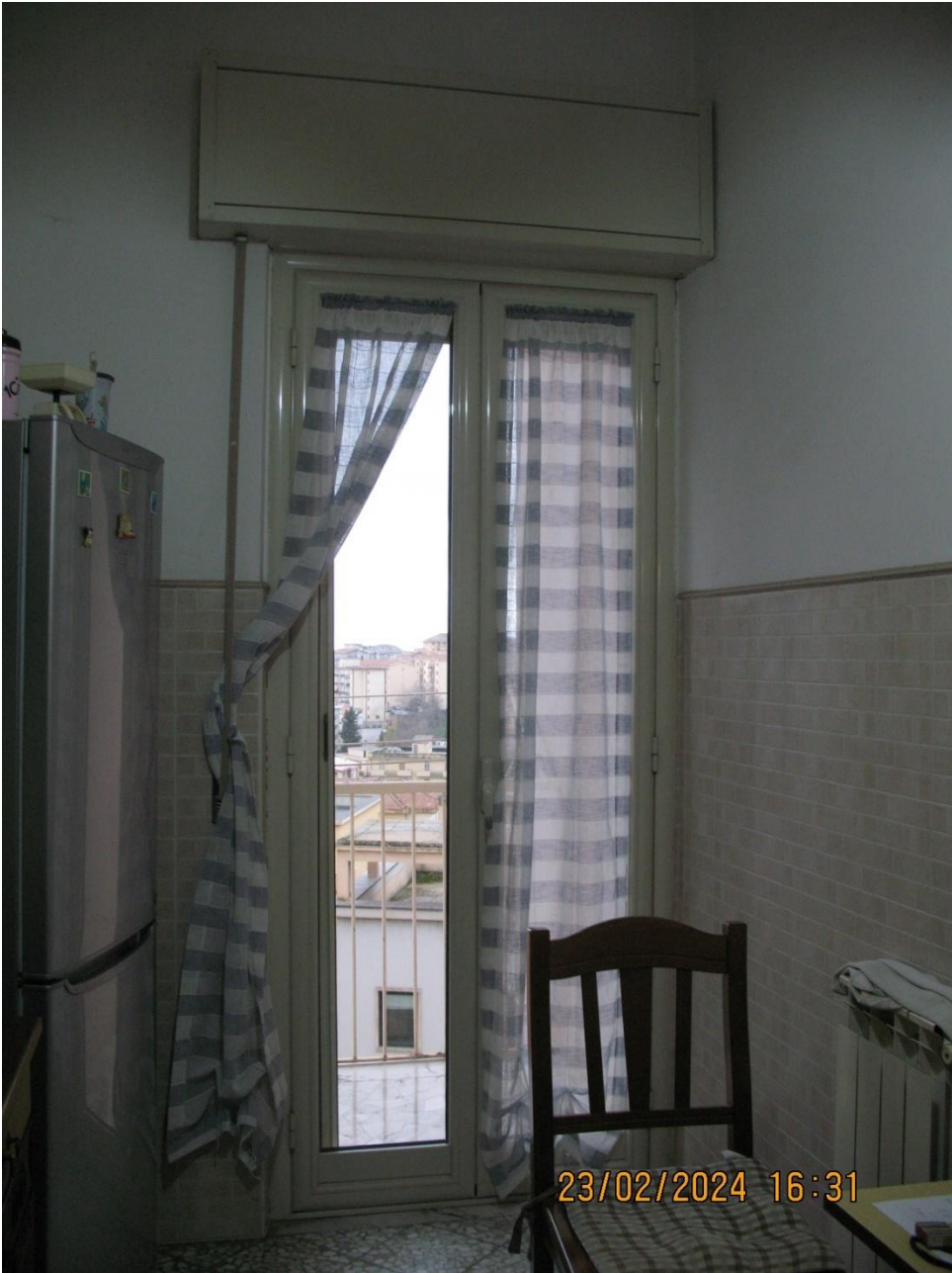
31-Cucina lato sud su Via Gorizia con apertura su balcone esterno
