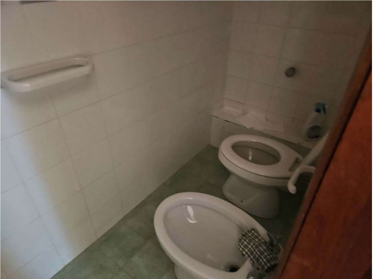
FOTO 21 piano seminterrato garage - Fiumefreddo Bruzio (CS)
