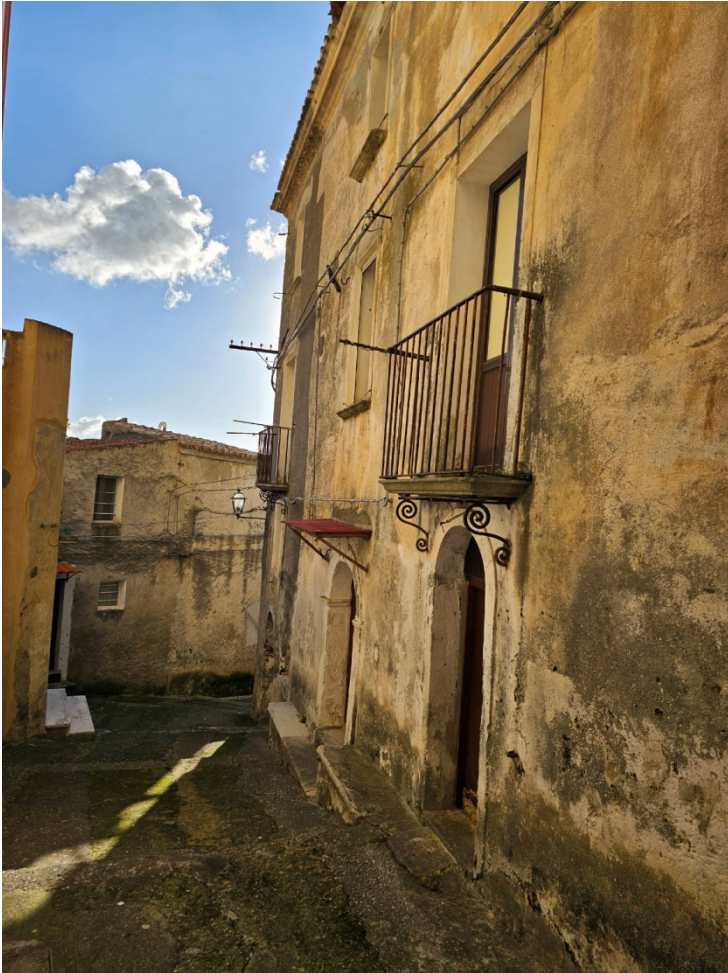
FOTO 01 esterno del fabbricato - Longobardi (CS)
