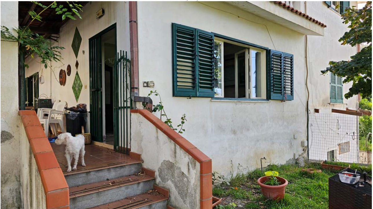
FOTO 08 esterno del fabbricato - Fiumefreddo Bruzio (CS)
