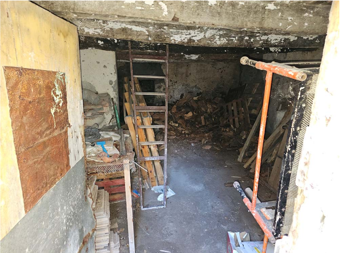
FOTO 06 interno cantina esterna - Longobardi (CS)
