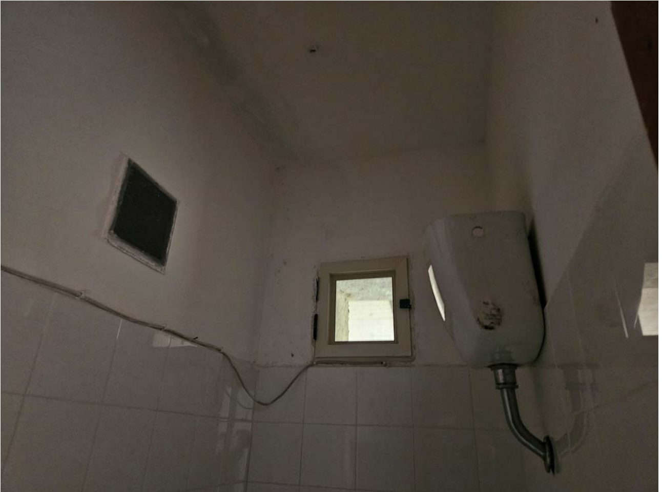
FOTO 22 piano seminterrato garage - Fiumefreddo Bruzio (CS)
