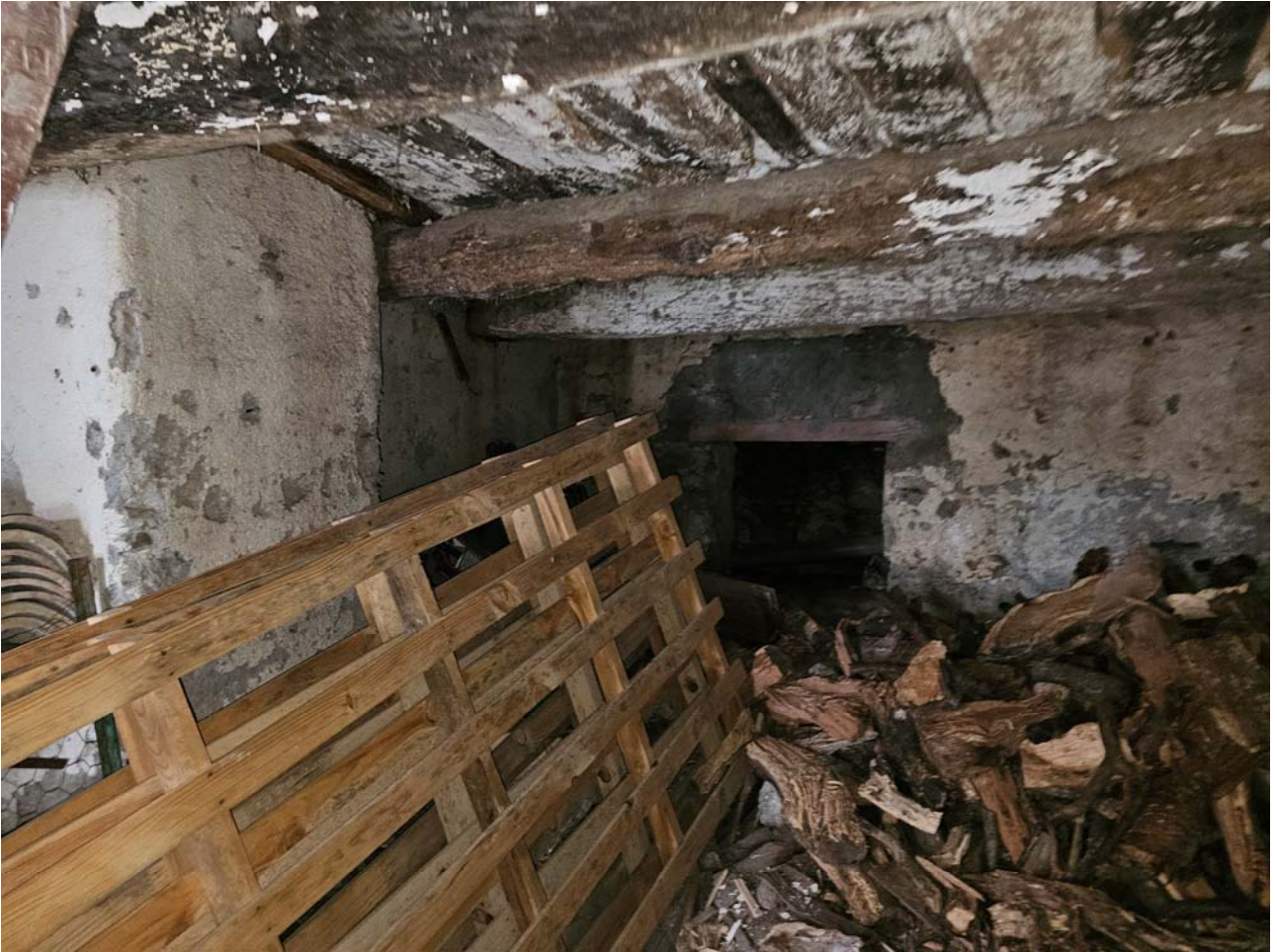
FOTO 07 interno cantina esterna - Longobardi (CS)
