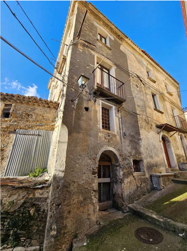
FOTO 04 esterno del fabbricato - Longobardi (CS)
