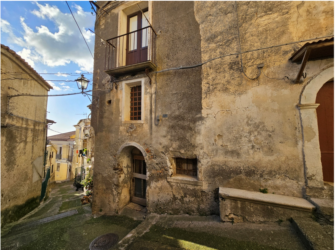
FOTO 02 esterno del fabbricato - Longobardi (CS)
