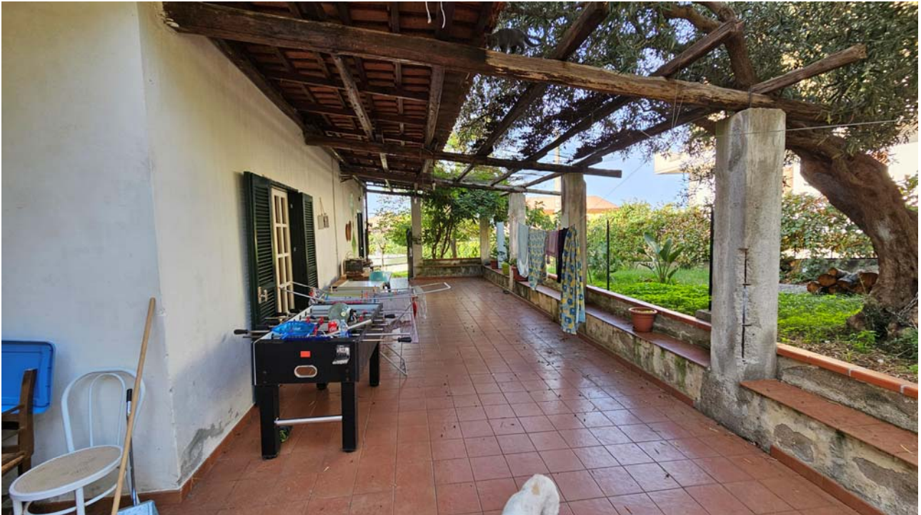
FOTO 10 esterno del fabbricato - Fiumefreddo Bruzio (CS)
