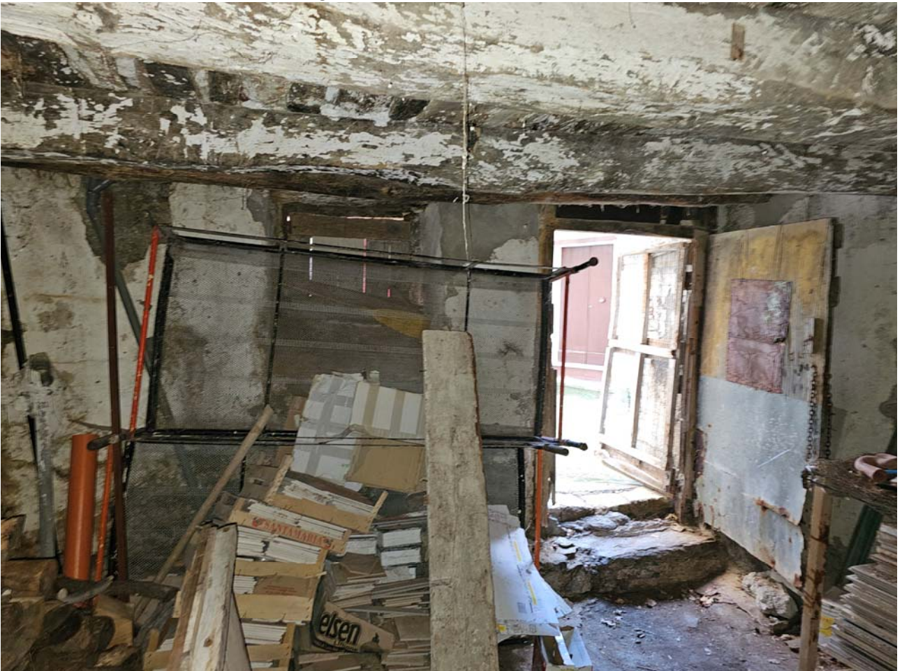
FOTO 08 interno cantina esterna - Longobardi (CS)
