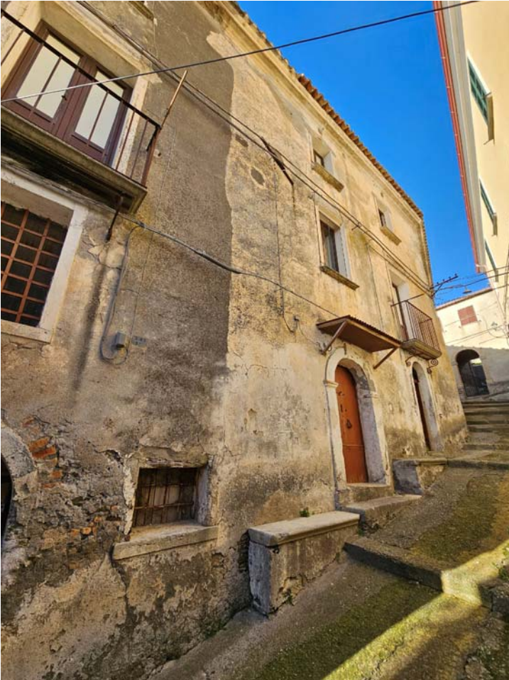
FOTO 03 esterno del fabbricato - Longobardi (CS)
