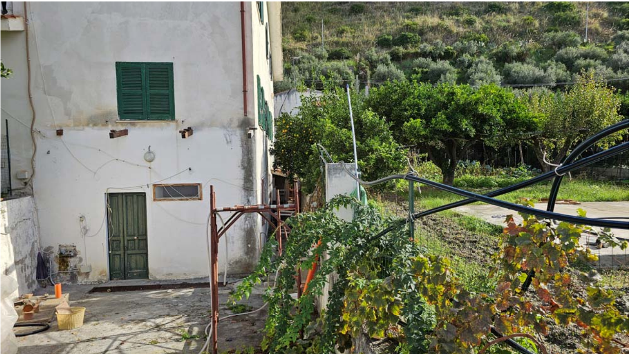
FOTO 04 esterno del fabbricato - Fiumefreddo Bruzio (CS)
