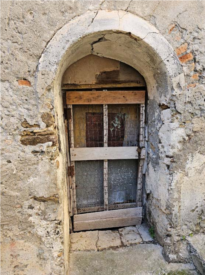
FOTO 05 interno cantina esterna - Longobardi (CS)
