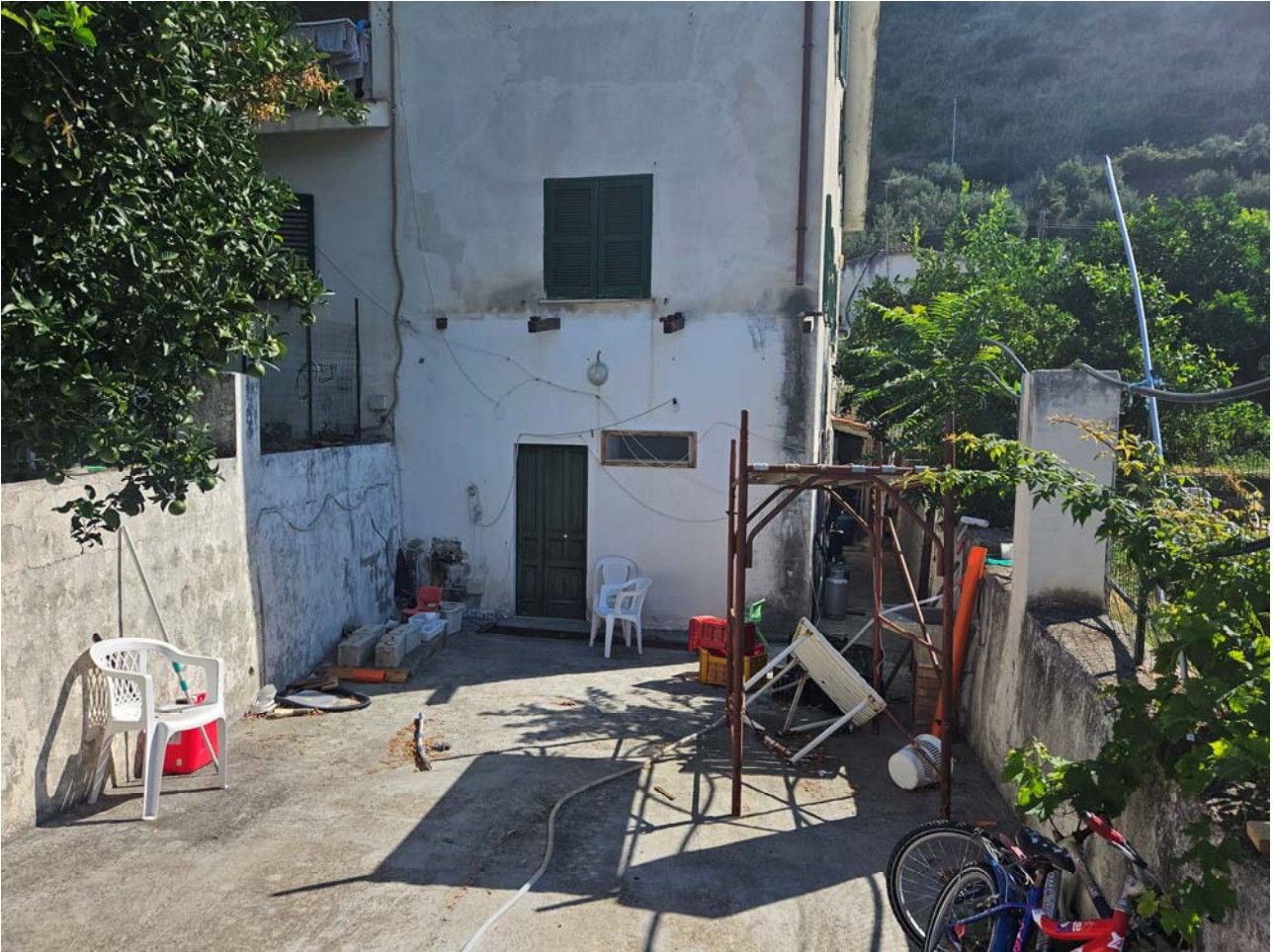
FOTO 03 esterno del fabbricato - Fiumefreddo Bruzio (CS)
