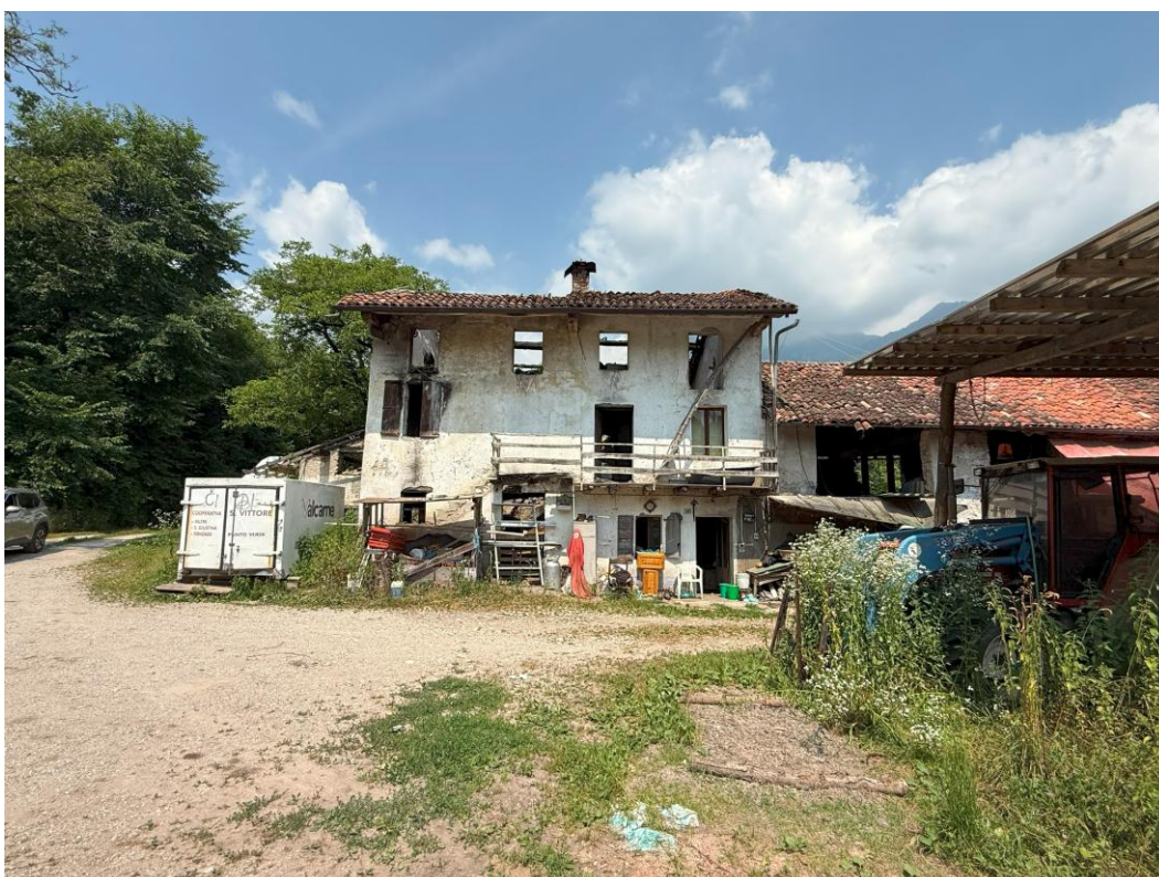
Foto 03: ex abitazione fronte Sud-Est
