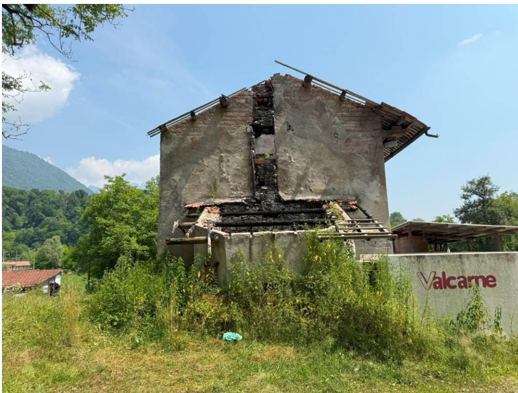
Foto 01: ex abitazione all'estremità Sud-Ovest (sub. 2)
