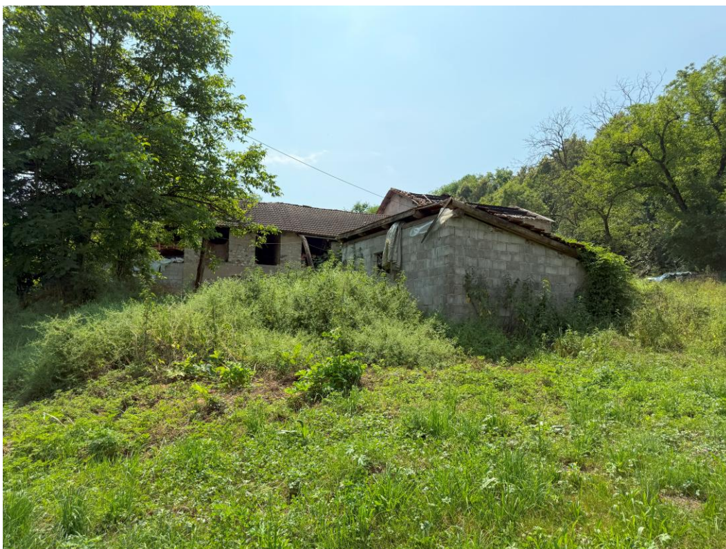
Foto 06: ricovero abusivo insistente sulla particella 521
