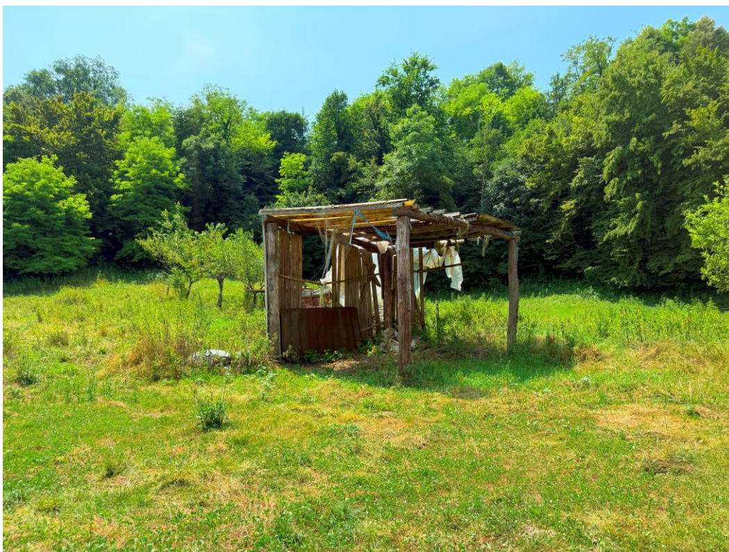
Foto 07: tettoia abusiva insistente sulla particella 127
