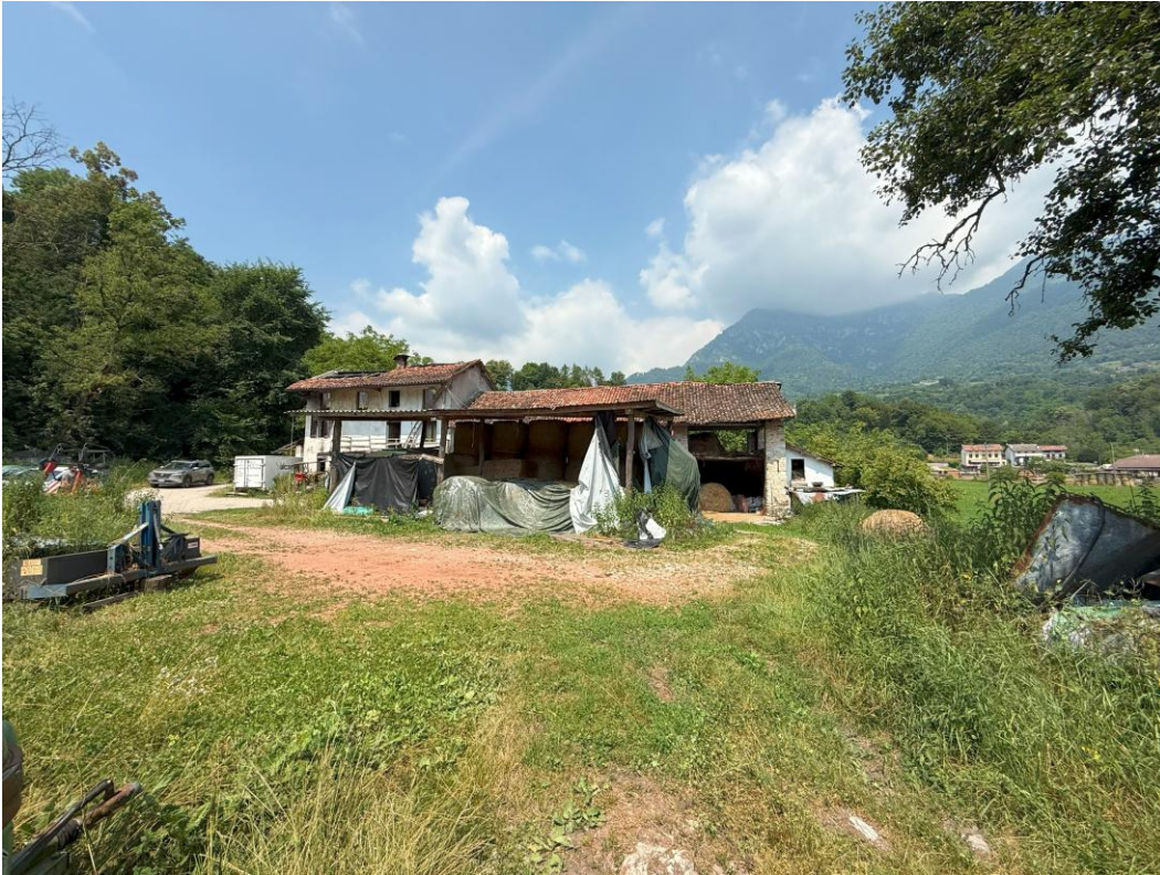
Foto 04: fronte Sud-Est ex abitazione e stalla-fienile con antistante tettoia abusiva
