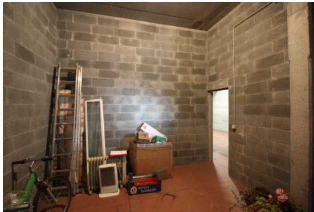
VISTA LAVANDERIA COMUNE – SUB.19
