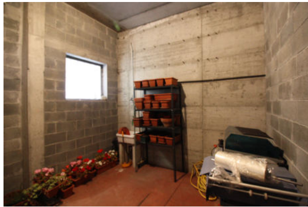
VISTA LAVANDERIA COMUNE – SUB.19
