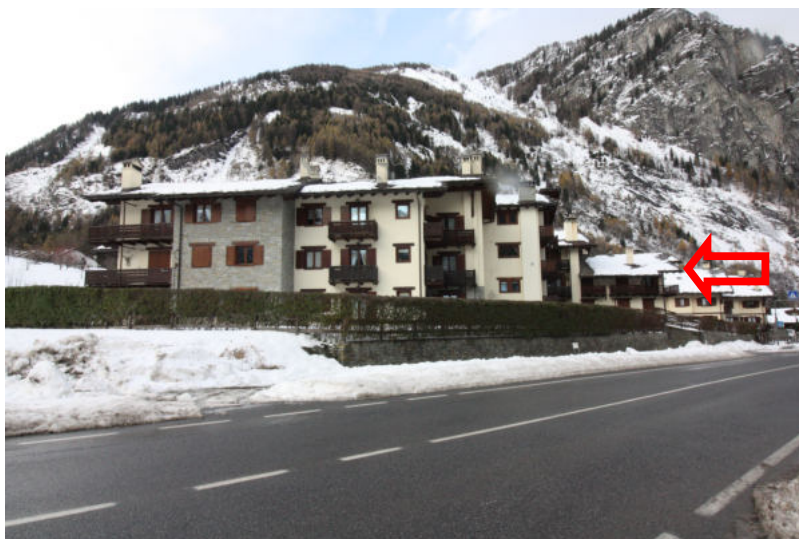
VISTA DALLA STRADA STATALE 26 – VISTA OVEST La freccia indica l'immobile d'interesse
