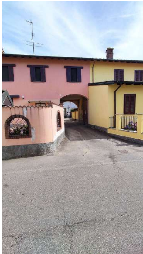
Accesso alla corte comune dalla via pubblica
