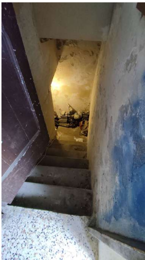
Rampa scala di accesso al piano interrato
