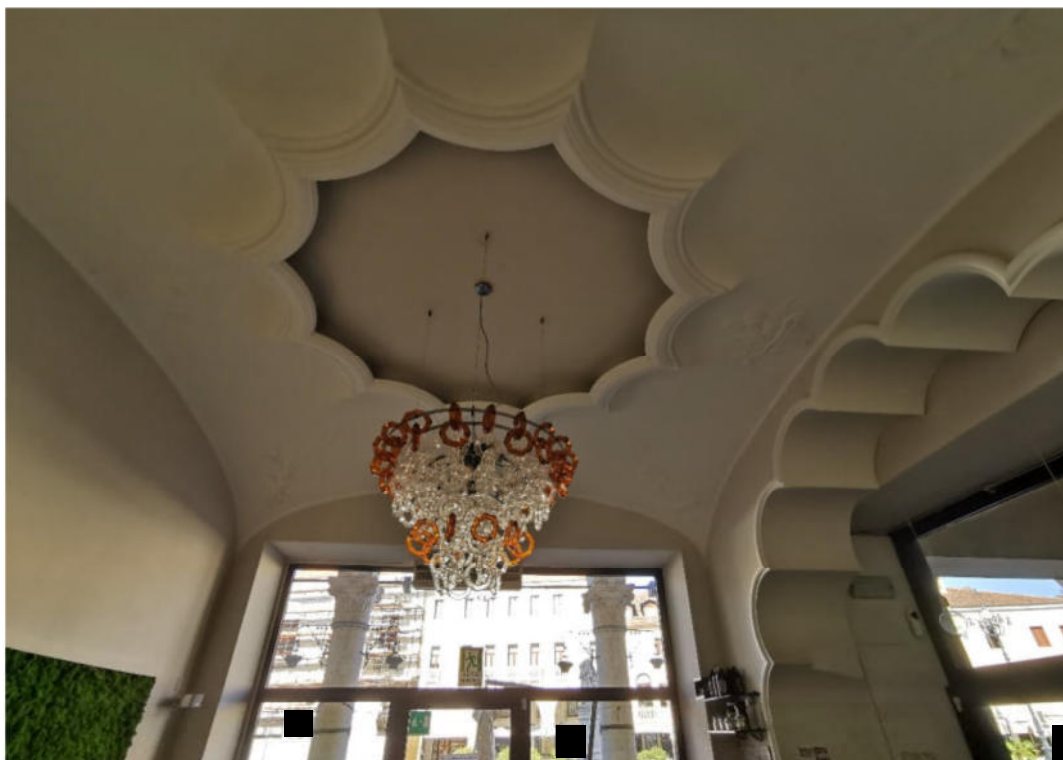
FOTOGRAFIA N.3 – particolare interno bar – piano terra
