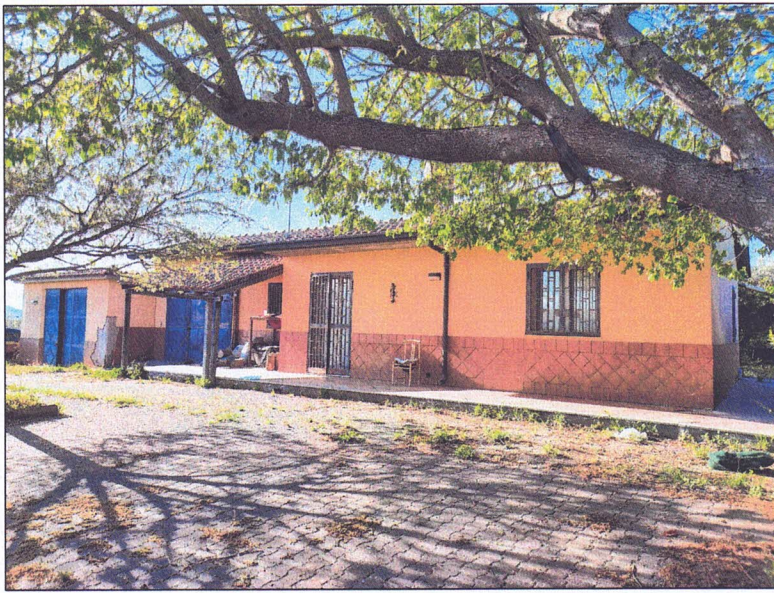
foto 6-7 - Foto del prospetto sud dell'abitazione avente la facciata rifinita con intonaco ed in buono stato conservativo. Da qui si accede alla camera 3 e al deposito.
