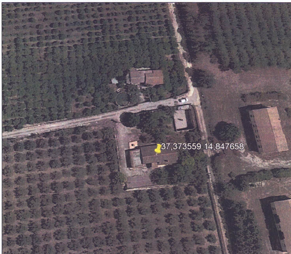
foto 3 - Vista dall'alto del fabbricato rurale adibito ad abitazione e deposito, dell'area circostante con vasca di raccolta d'acqua e un casotto.
