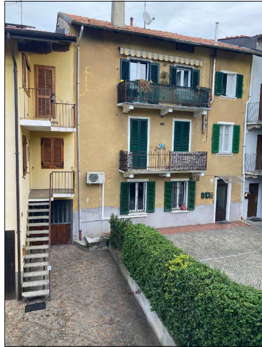
Foto 17 - BALCONE CAMERA: VISTA FRONTALE
