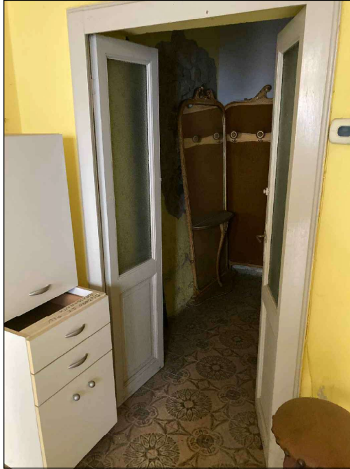
Foto 08 - PORTA VERSO DISIMPEGNO
