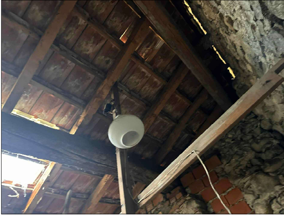
Foto 23 - SOTTOTETTO: DETTAGLIO TETTO
