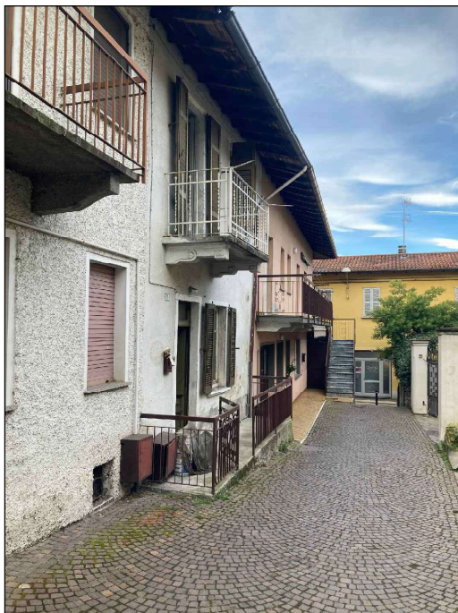
Foto 03 - VISTA IMMOBILE DA EST
