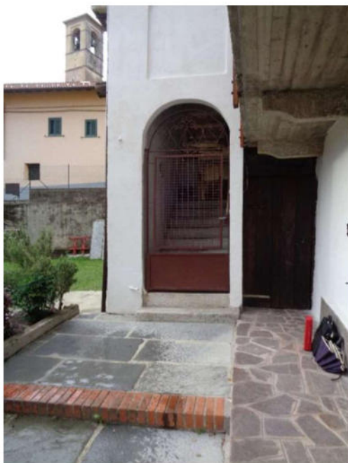
Ingresso scala accesso all'Immobile al Piano Secondo
