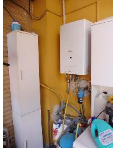
_balcone (lato interno)
