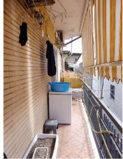
_balcone (prospettante su via Tevere)
