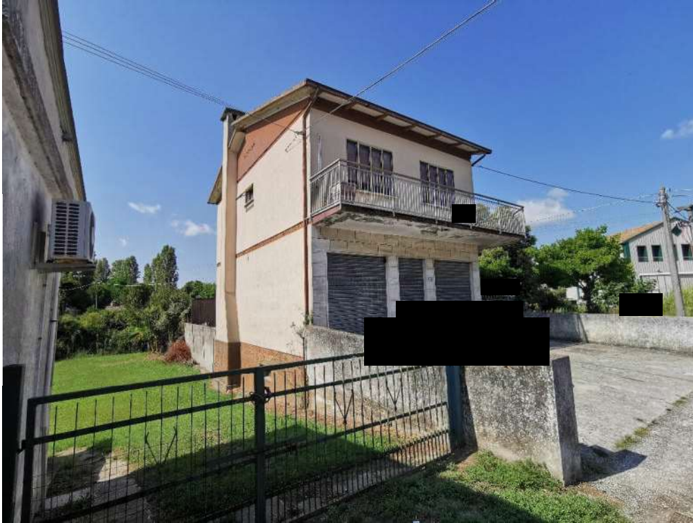
FOTOGRAFIA N.1 - particolare prospetto principale
