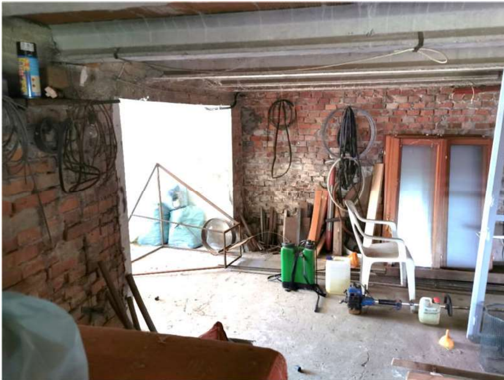
FOTOGRAFIA N.13 - particolare interno locali sottostanti il negozio
