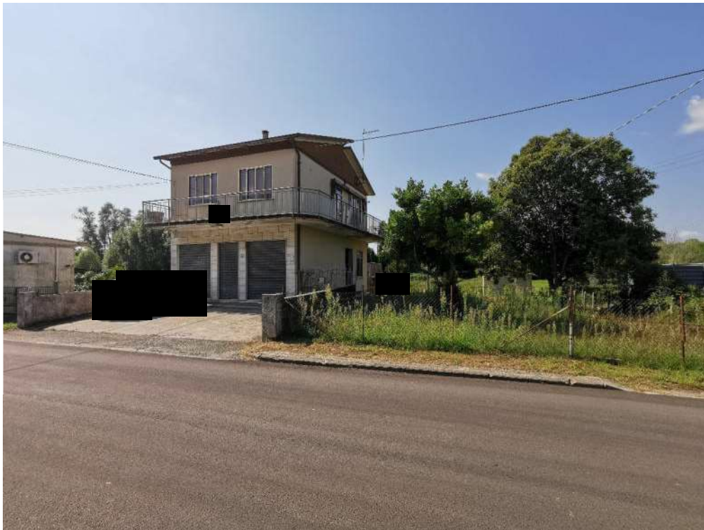
FOTOGRAFIA N.2 - particolare prospetto principale
