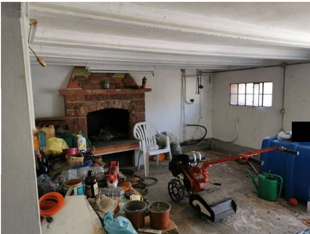
FOTOGRAFIA N.12 - particolare interno locali sottostanti il negozio
