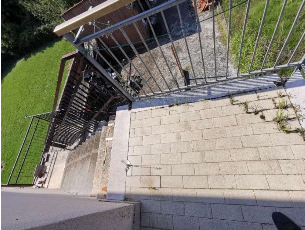
FOTOGRAFIA N.11 - particolare scala esterna e poggiolo
