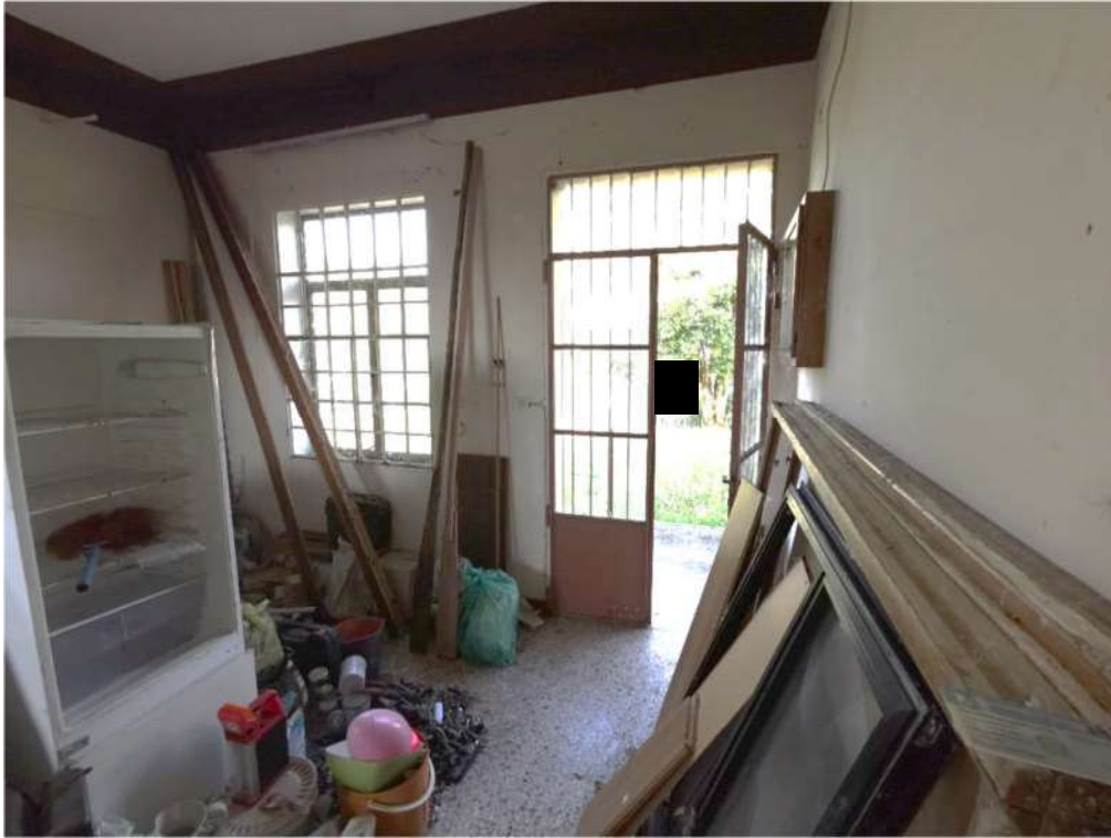
FOTOGRAFIA N.5 - particolare interno retro - bottega
