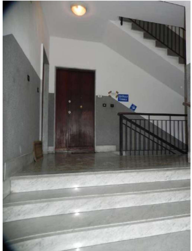
Foto 12 - Vista dell'androne di ingresso
