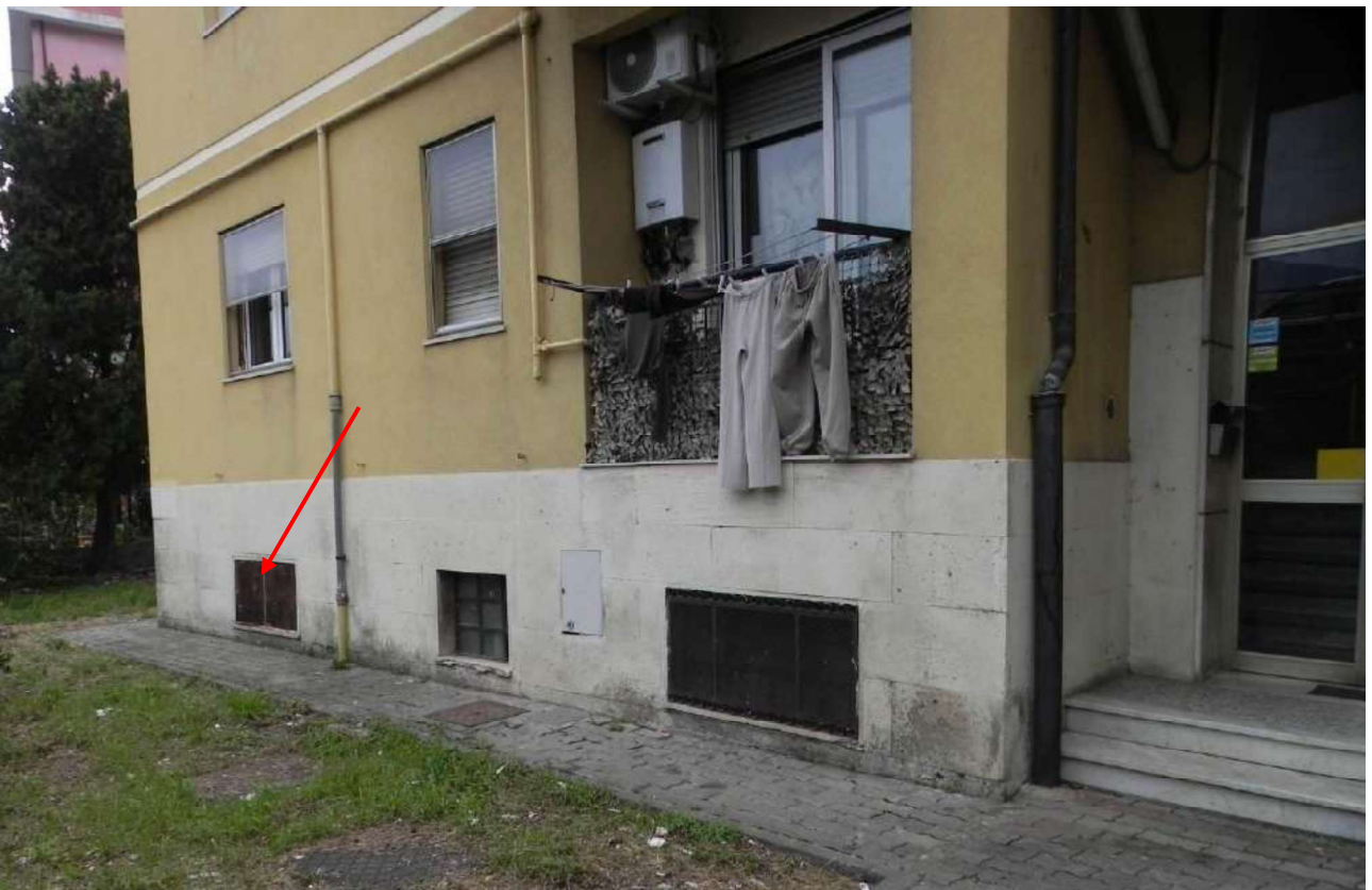
Foto 10 - Vista esterna dell'edificio
