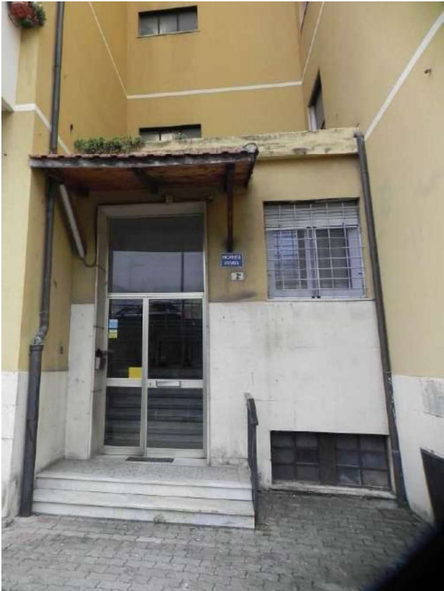
Foto 11 - Vista del portone di ingresso
