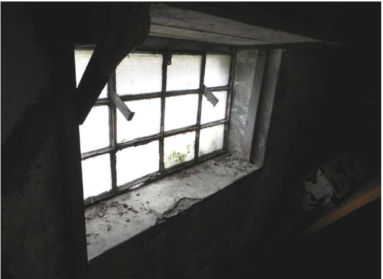
Foto 19 – Foto della finestra della cantina Subalterno 27 oggetto di procedura
