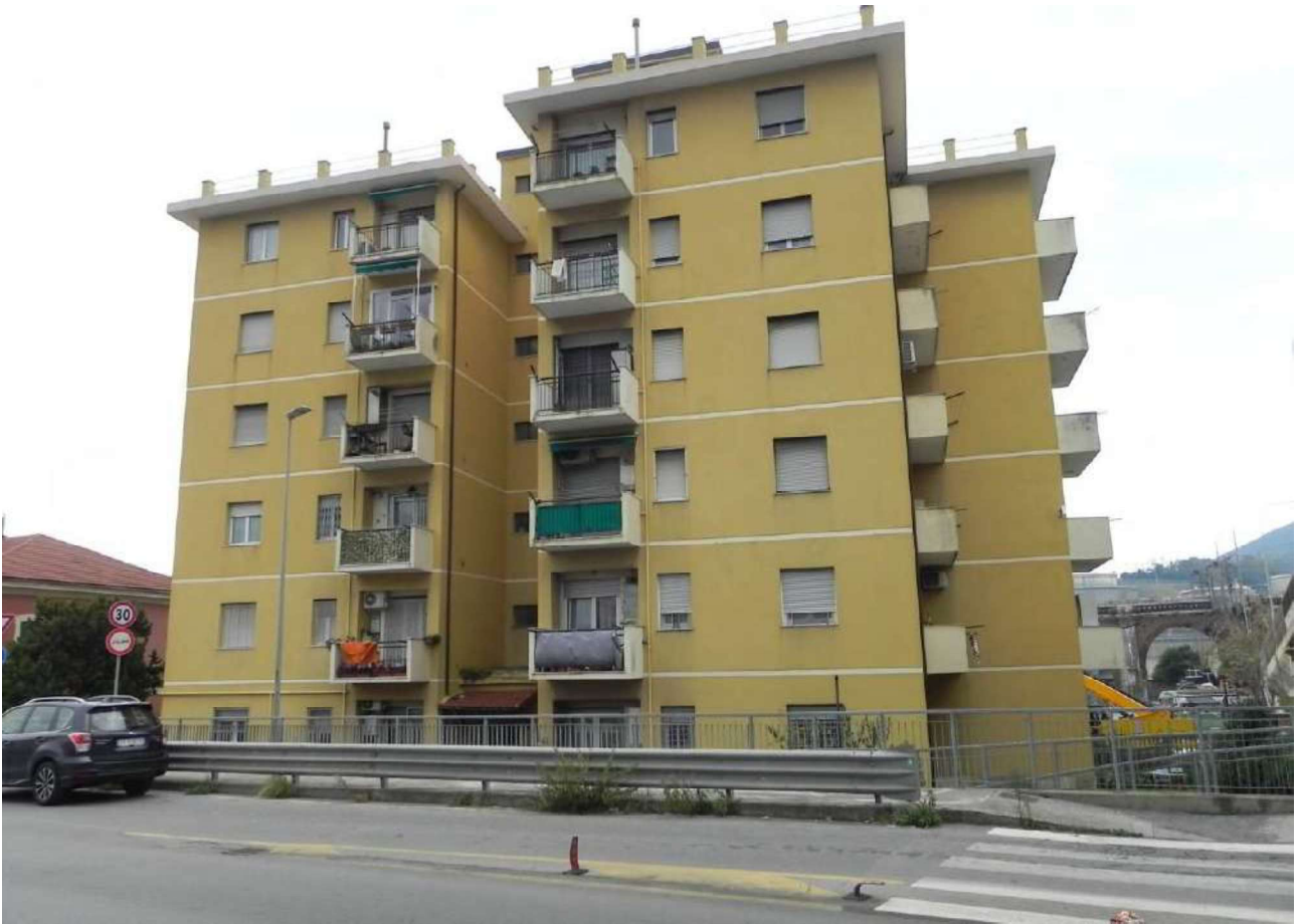
Foto 9 - Vista esterna dell'edificio
