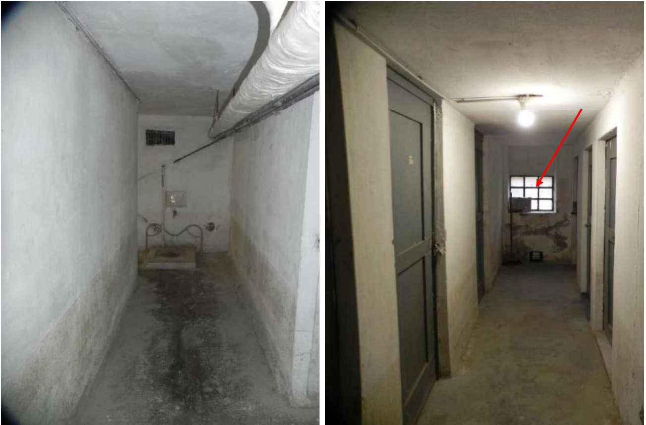
Foto 15 e 16 - Viste della scala di accesso all'andito delle cantine per raggiungere la cantina Subalterno 27 oggetto di procedura In evidenza la finestra del corridoio a fianco della cantina Subalterno 27 oggetto di procedura
