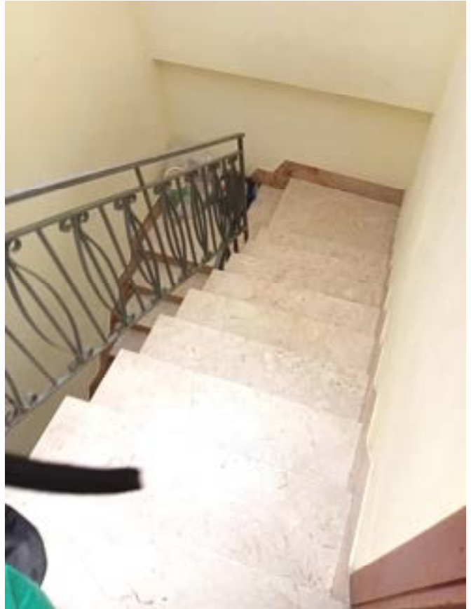
Foto 10: " Corpo scala del fabbricato che collega il secondo piano al terzo"
