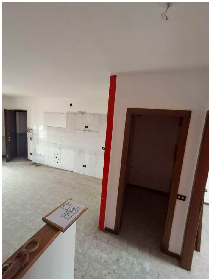
9) Veduta soggiorno e ripostiglio
