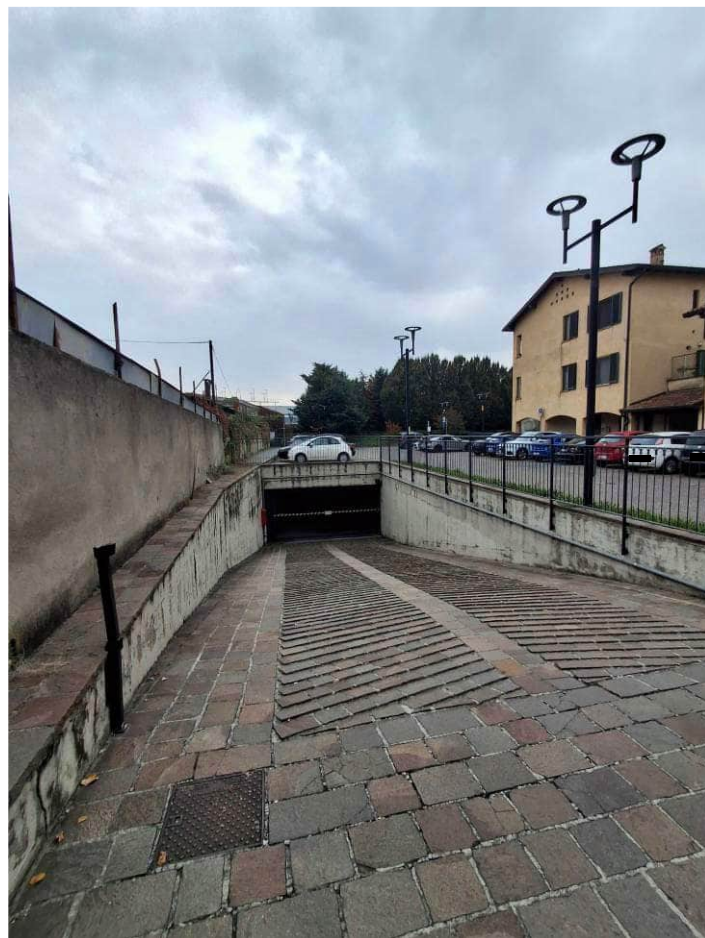
16) Rampa di accesso alle autorimesse
