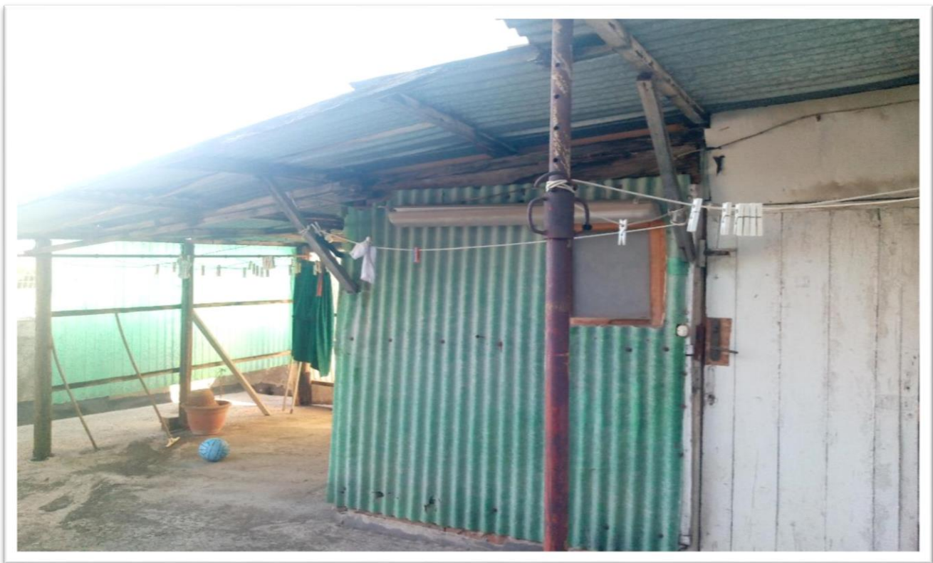
Foto 14: laterale della struttura
