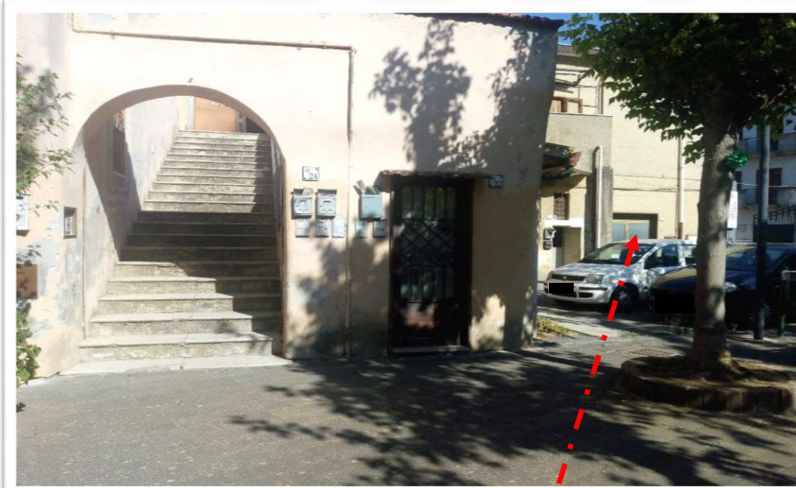
Foto 1: Accesso al garage
