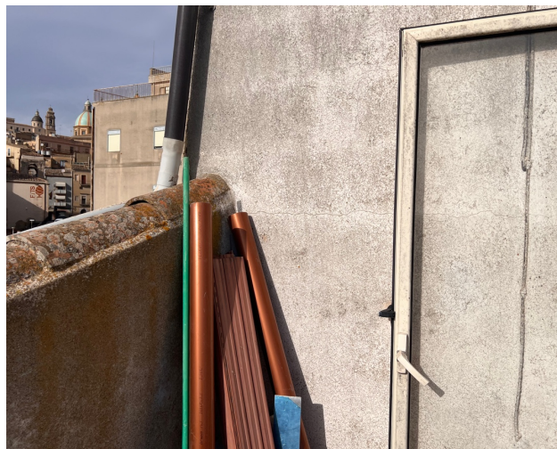
Figura 23 – Terrazzino lato camera da letto, particolare del muro esterno e del parapetto lato nord-ovest
