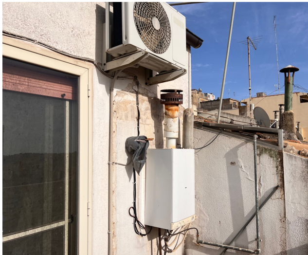
Figura 8 – Terrazzino lato sud-ovest
