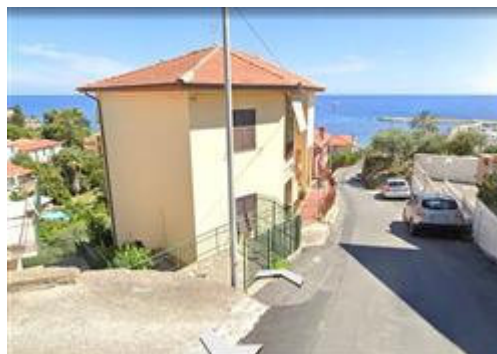
FOTO PANORAMICA DEL FABBRICATO
