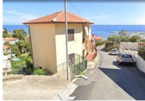
FOTO PANORAMICA DEL FABBRICATO
