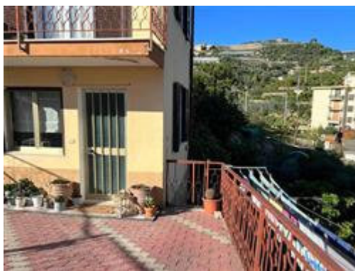
entrata appartamento e scaletta per scendere al vano caldaia
