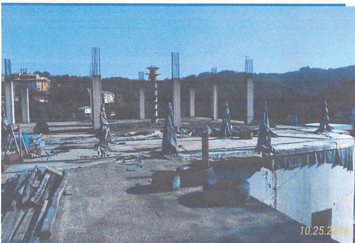
Foto 4 – IMMOBILE A – Solaio di copertura, senza alcuna finitura
