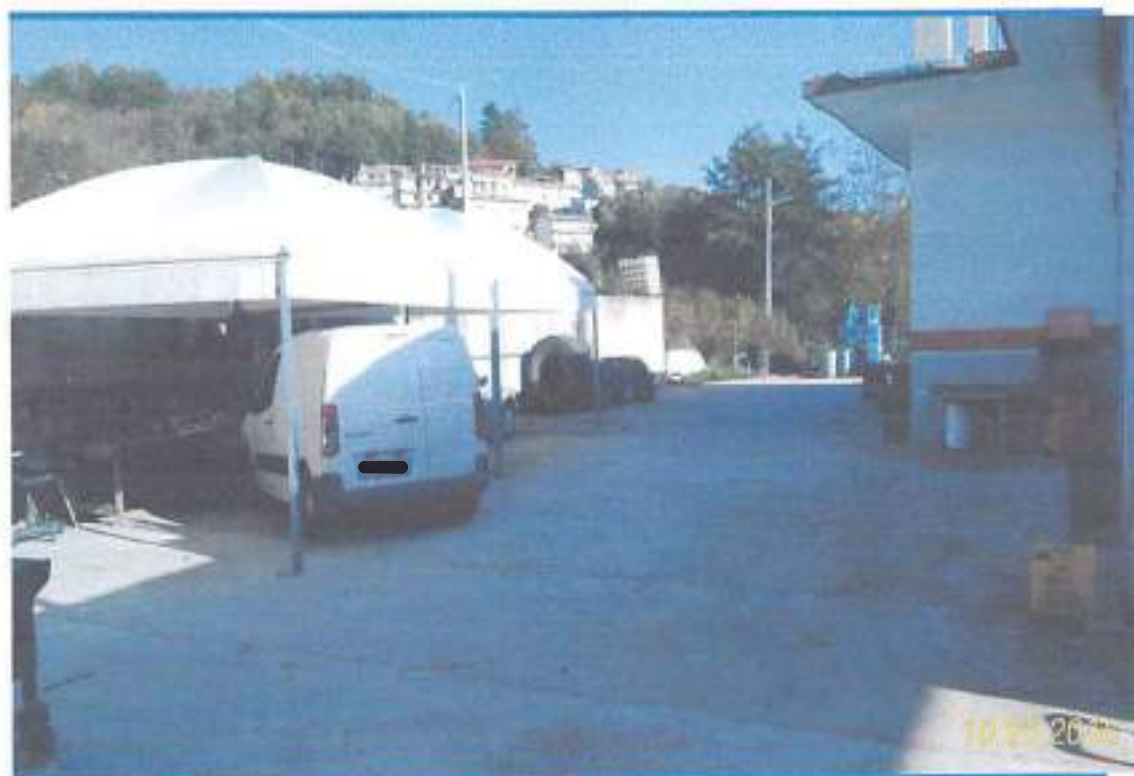
Foto 2 – IMMOBILE A – Vista retro con impianto autolavaggio
