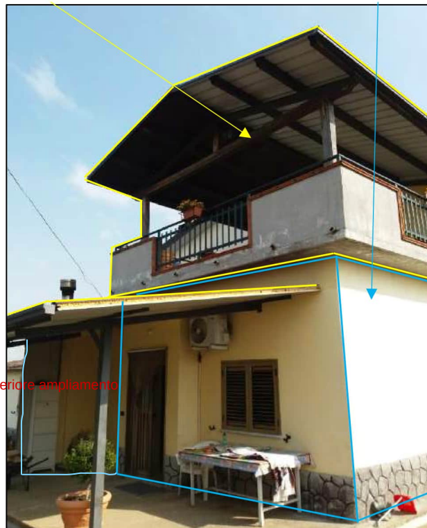
Foto D – Lato Sud-Est
