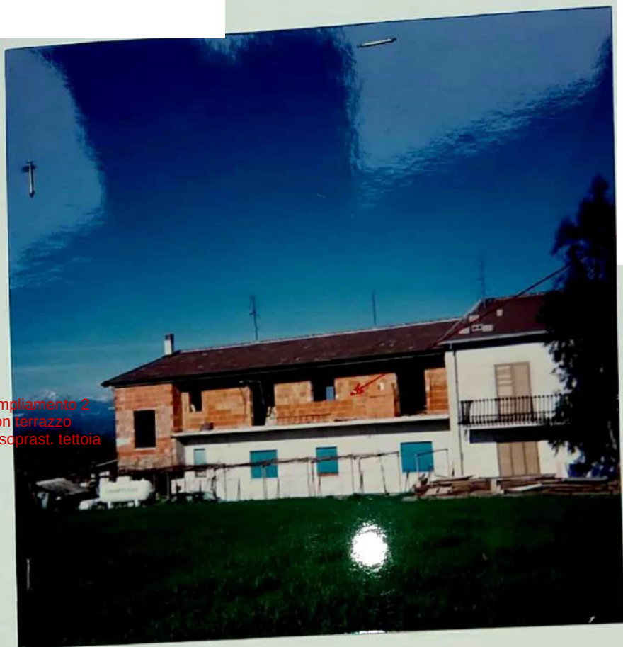
Foto n. 3 - Piano Primo, Lato Est
