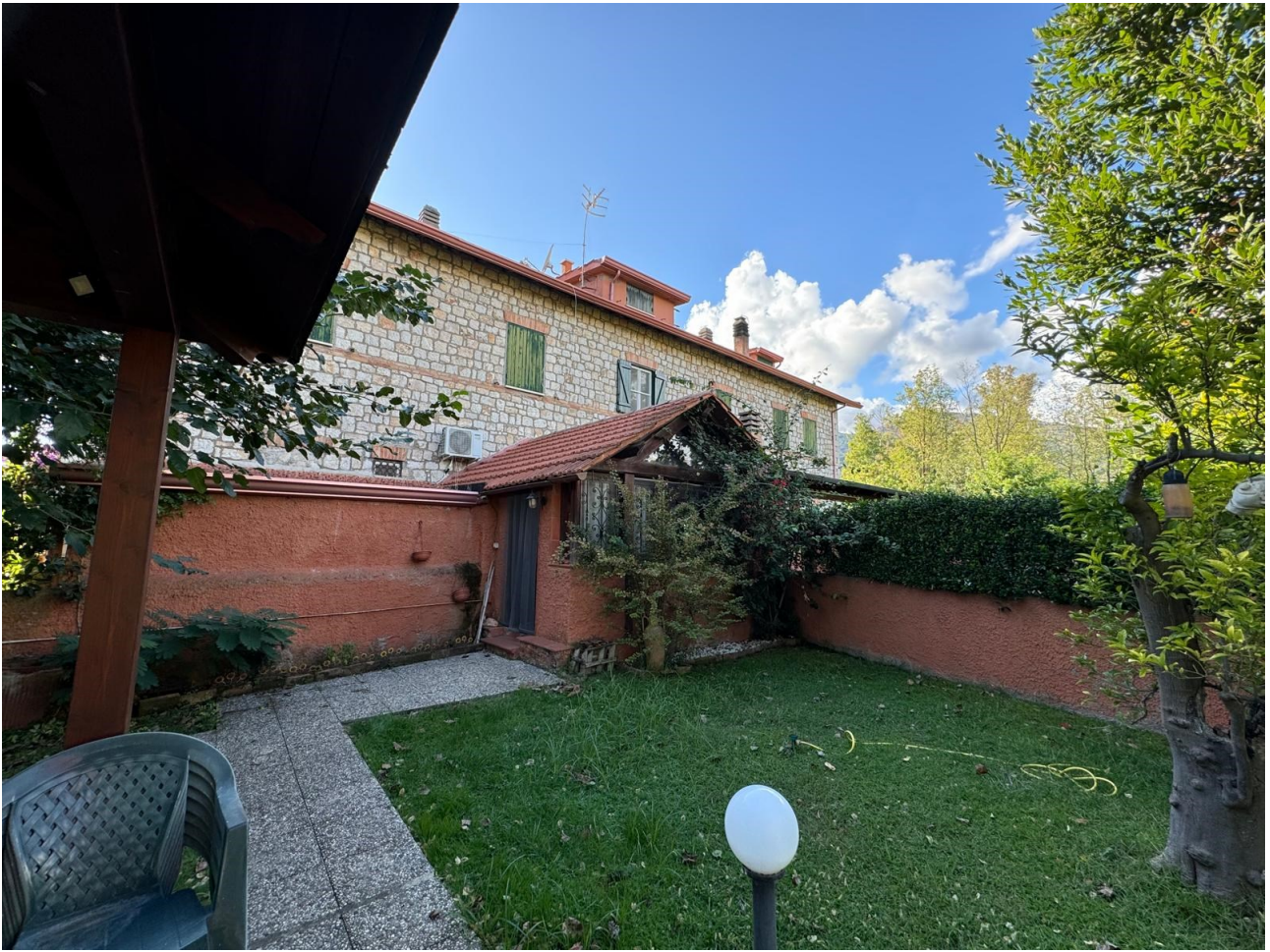
ESTERNO AMPLIAMENTO ABUSIVO
