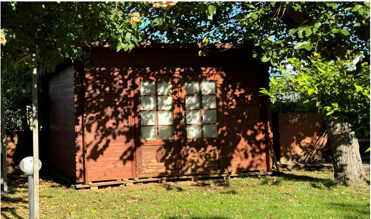
STRUTTURA IN LEGNO PREFABRICATA NON INFISSA A TERRA DA RIMOMUOVERE
