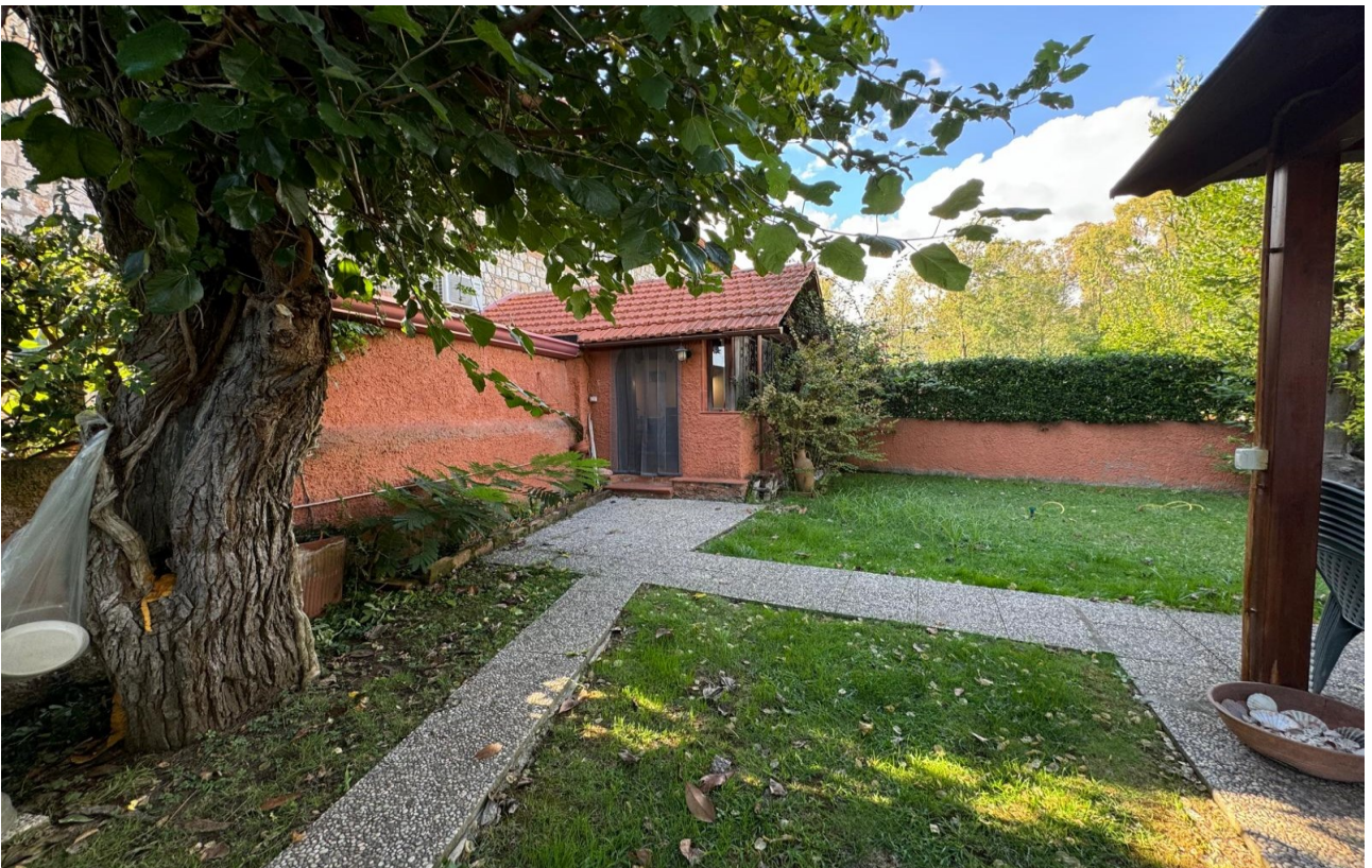
ESTERNO AMPLIAMENTO ABUSIVO
