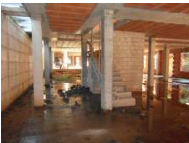
Foto 19. Vista Piano seminterrato
