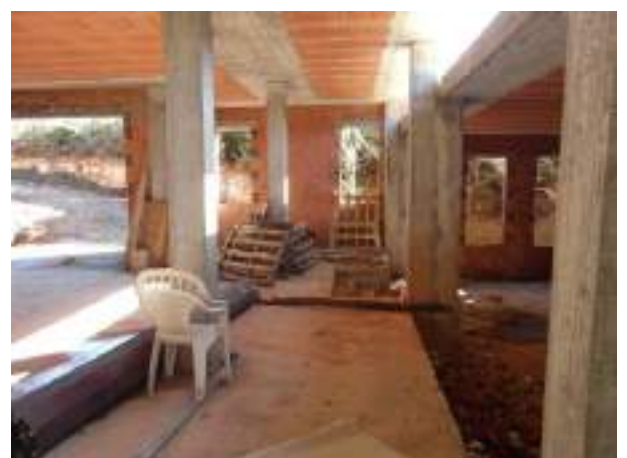
Foto 14. Vista Piano seminterrato
