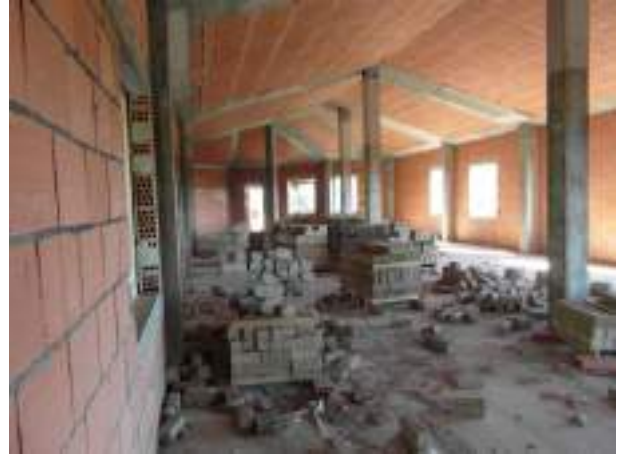
Foto 40. Vista interna Piano Terra corpo C
