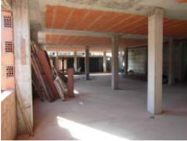
Foto 9. Vista Piano seminterrato
