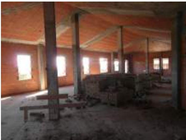
Foto 41. Vista interna Piano Terra corpo C
