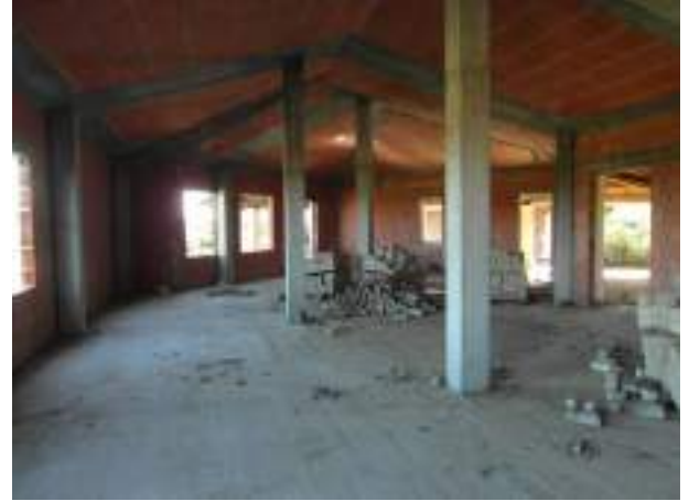
Foto 46. Vista interna Piano Terra corpo B
