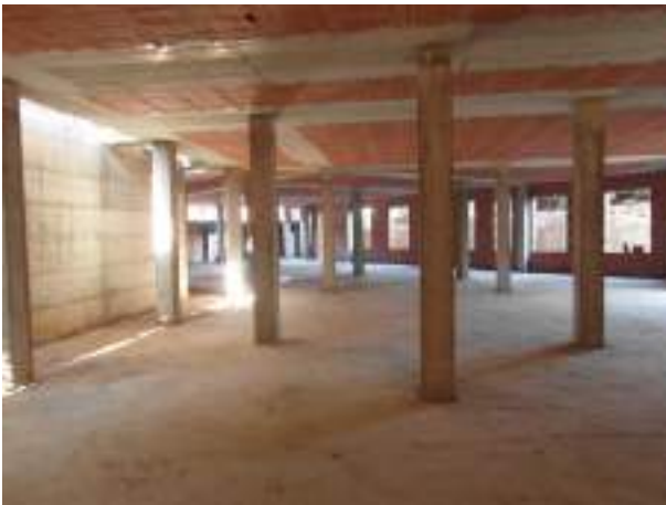
Foto 5. Vista Piano seminterrato
