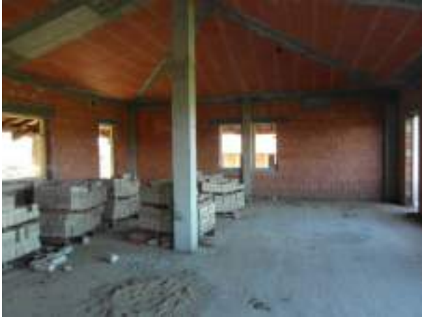
Foto 45. Vista interna Piano Terra corpo B
