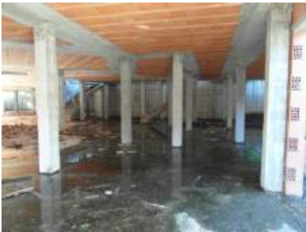
Foto 17. Vista Piano seminterrato
