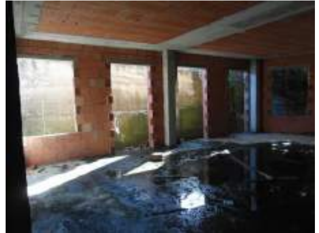
Foto 16. Vista Piano seminterrato
