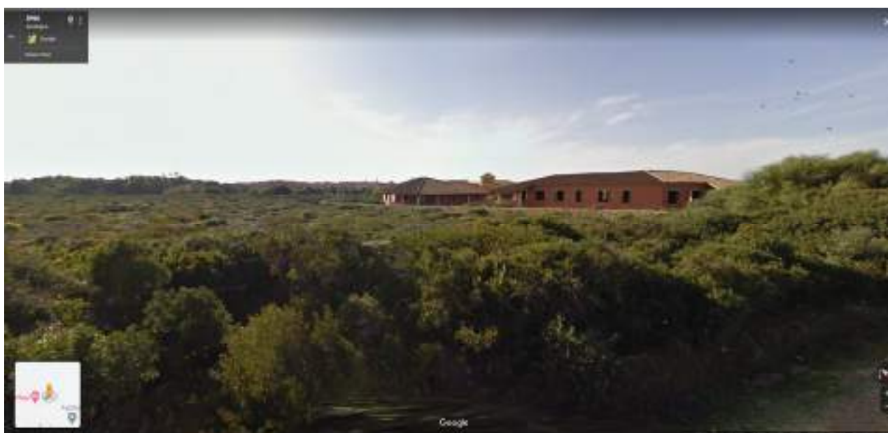
Foto 57 Vista Terreno F.45 mappale 1127 dalla strada SP66
