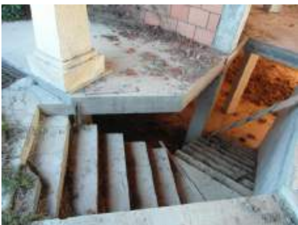
Foto 35. Scale di Accesso al piano seminterrato
