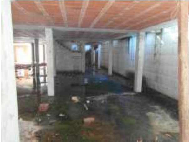
Foto 15. Vista Piano seminterrato
