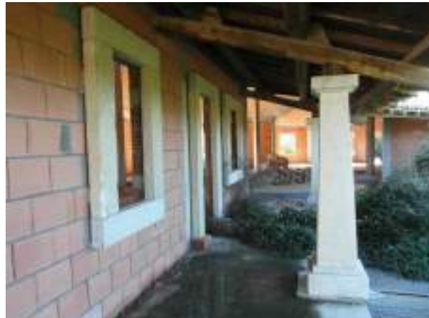
Foto 34. Vista Piano Terra particolare pilastro in granito giallo San Giacomo
