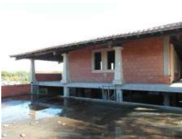
Foto 47. Vista interna Piano Terra corpo B
