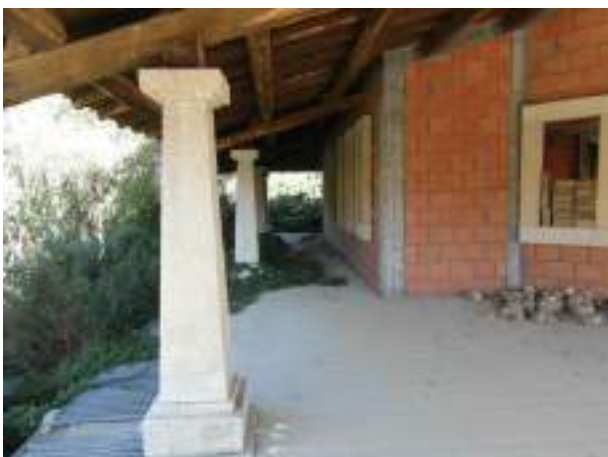
Foto 37. Vista Piano Terra particolare pilastro in granito giallo San Giacomo
