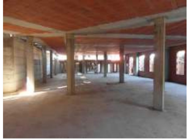
Foto 4. Vista Piano seminterrato
