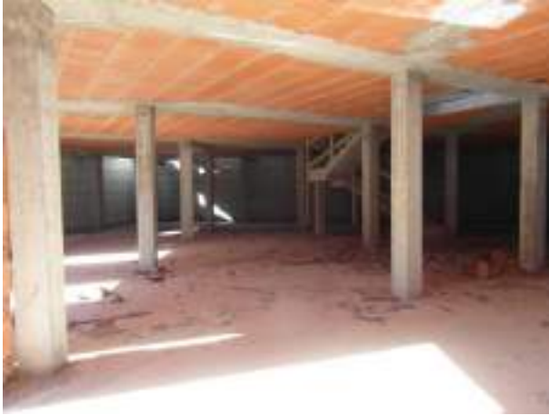
Foto 21. Vista Piano seminterrato
