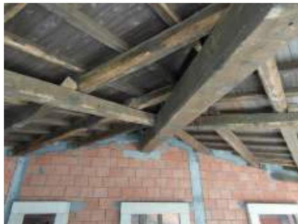
Foto 38. Vista Piano Terra particolare della copertura dei loggiati
