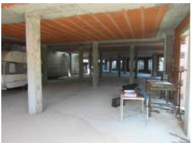
Foto 8. Vista Piano seminterrato
