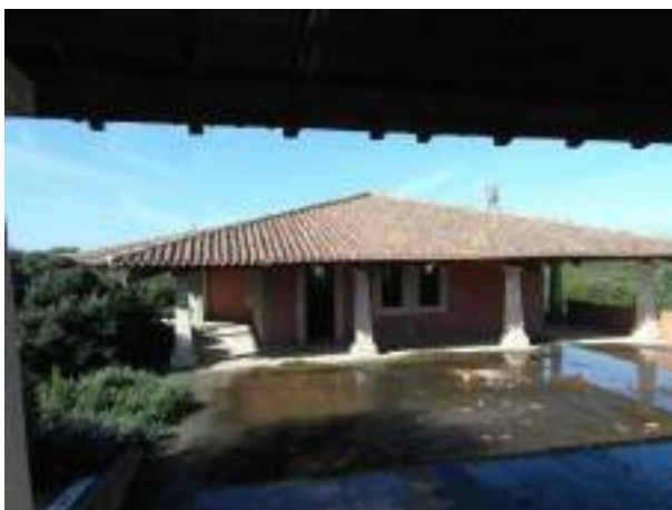
Foto 49. Vista Piano Terra corpo A esterno
