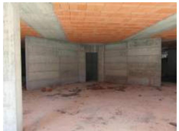
Foto 20. Vista Piano seminterrato
