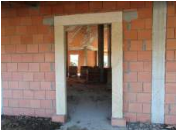
Foto 33. Piano Terra corpo D esterno particolare architrave e pilastri granito giallo San Giacomo
