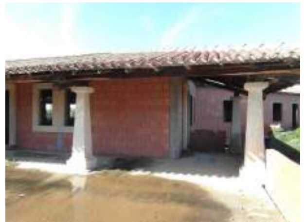
Foto 50. Vista Piano Terra corpo A esterno
