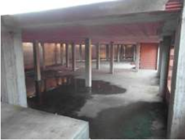
Foto 3. Vista Piano seminterrato
