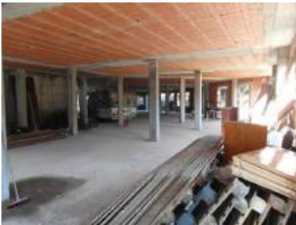
Foto 11. Vista Piano seminterrato
