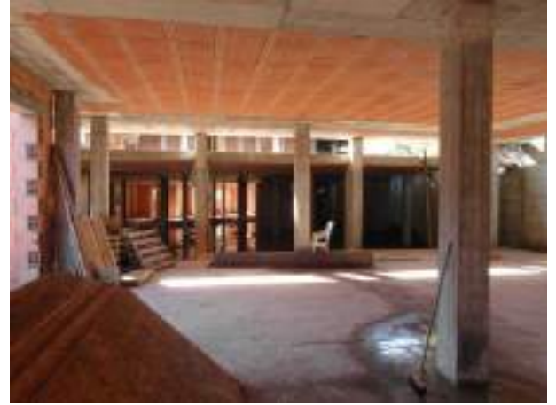
Foto 10. Vista Piano seminterrato
