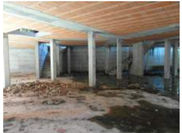
Foto 18. Vista Piano seminterrato
