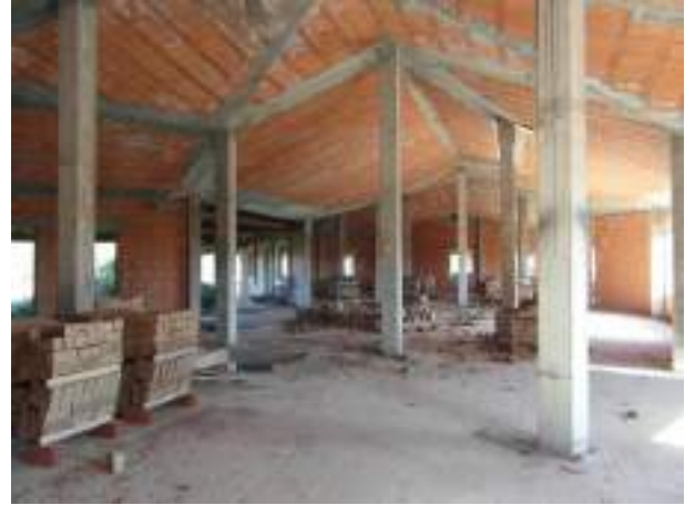
Foto 22. Vista Piano Terra
