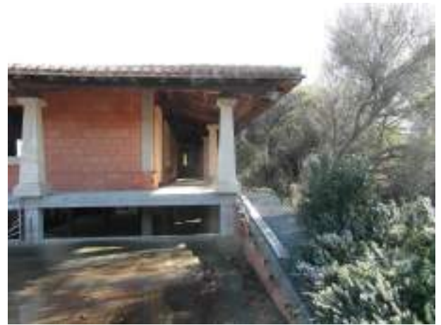
Foto 48. Vista interna Piano Terra corpo B
