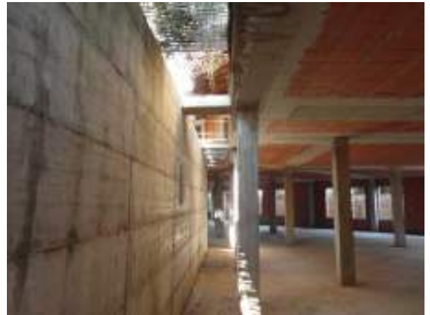
Foto 6. Vista Piano seminterrato
