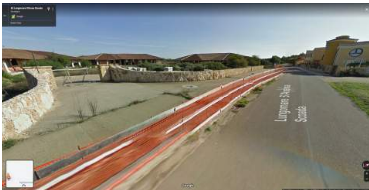
Foto 59 Vista Terreno F.45 mappal1 1128, 1129 destinati a marciapiedi della sede stradale dalla via S’Architeddu
