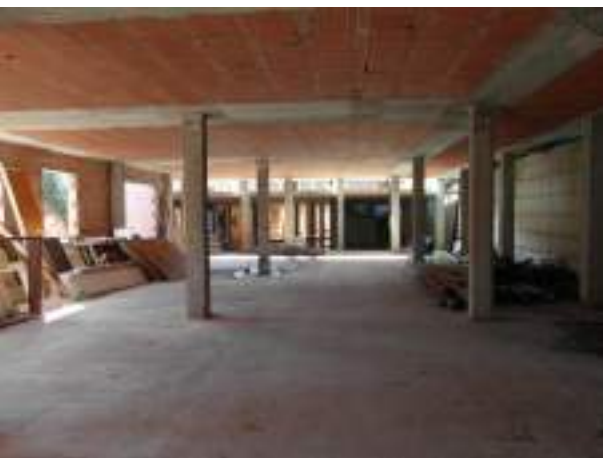
Foto 7. Vista Piano seminterrato
