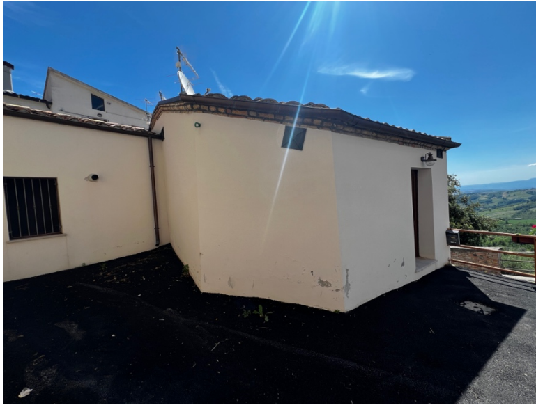
Foto n°5 – vista esterna, lato posteriore immobile
