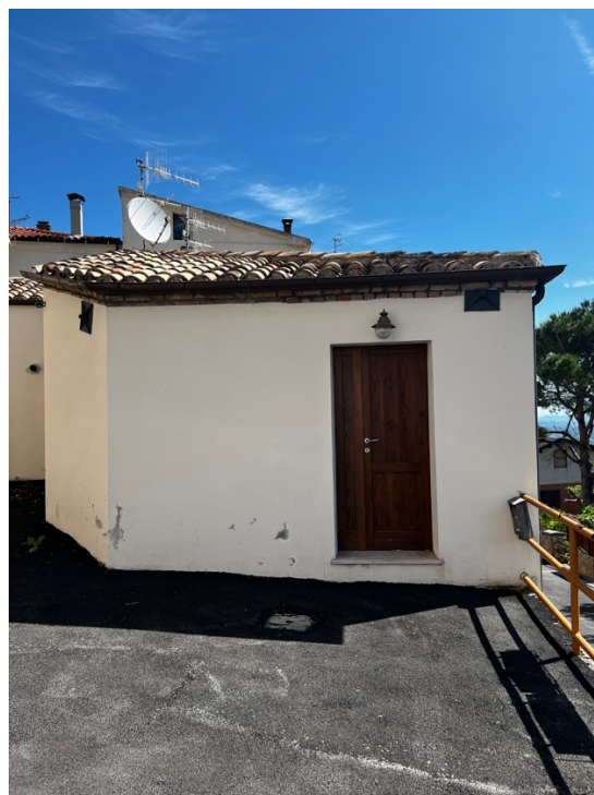
Foto n°3 e n°4 - vista esterna ingresso immobile
