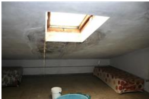
Soffitta con lucernaio
