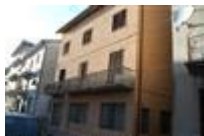
Prospetto sud fronte strada
