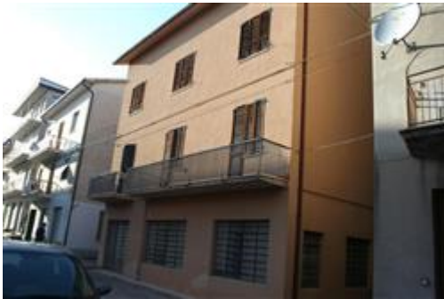
Prospetto sud fronte strada
