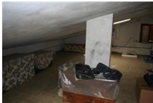
Soffitta vista verso est
