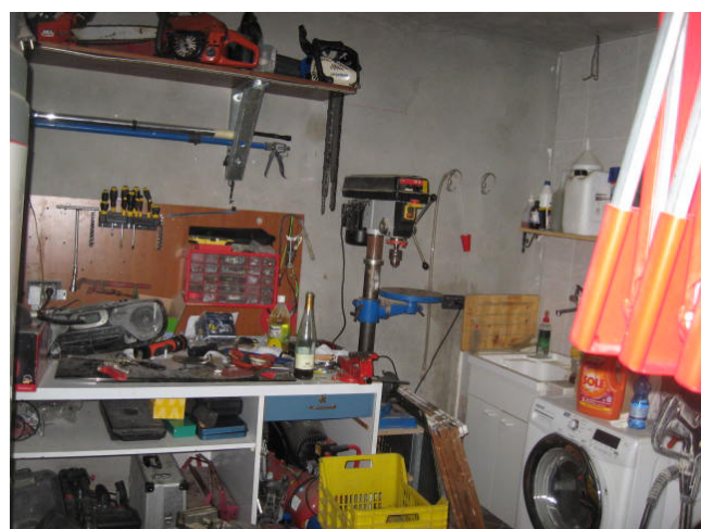
garage e pompa di calore
